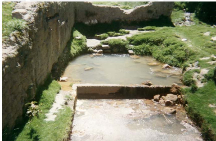
Fotografía 4. Vista del lugar de emergencia e infraestructura abandonada
