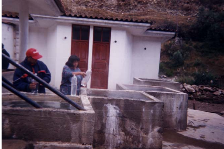
Fotografía 7. Vista de los tres puntos de emergencia remodelados
