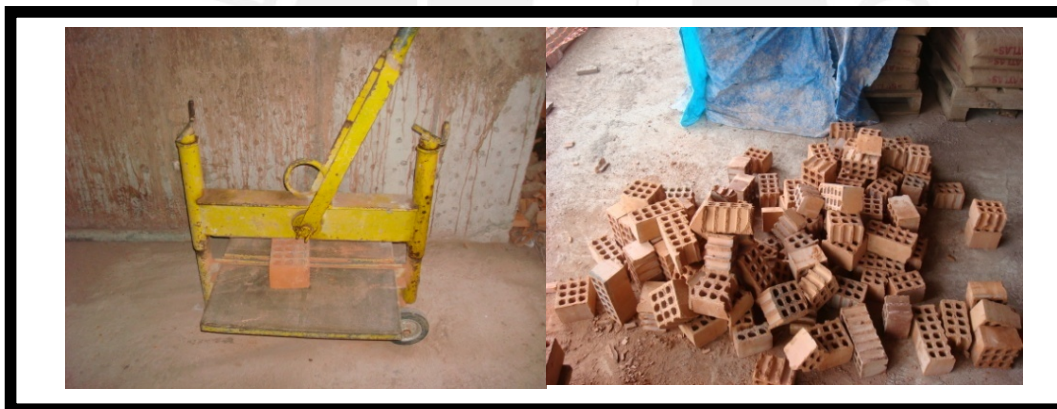
FOTO 3. Proceso de corte de las unidades de ladrillo
