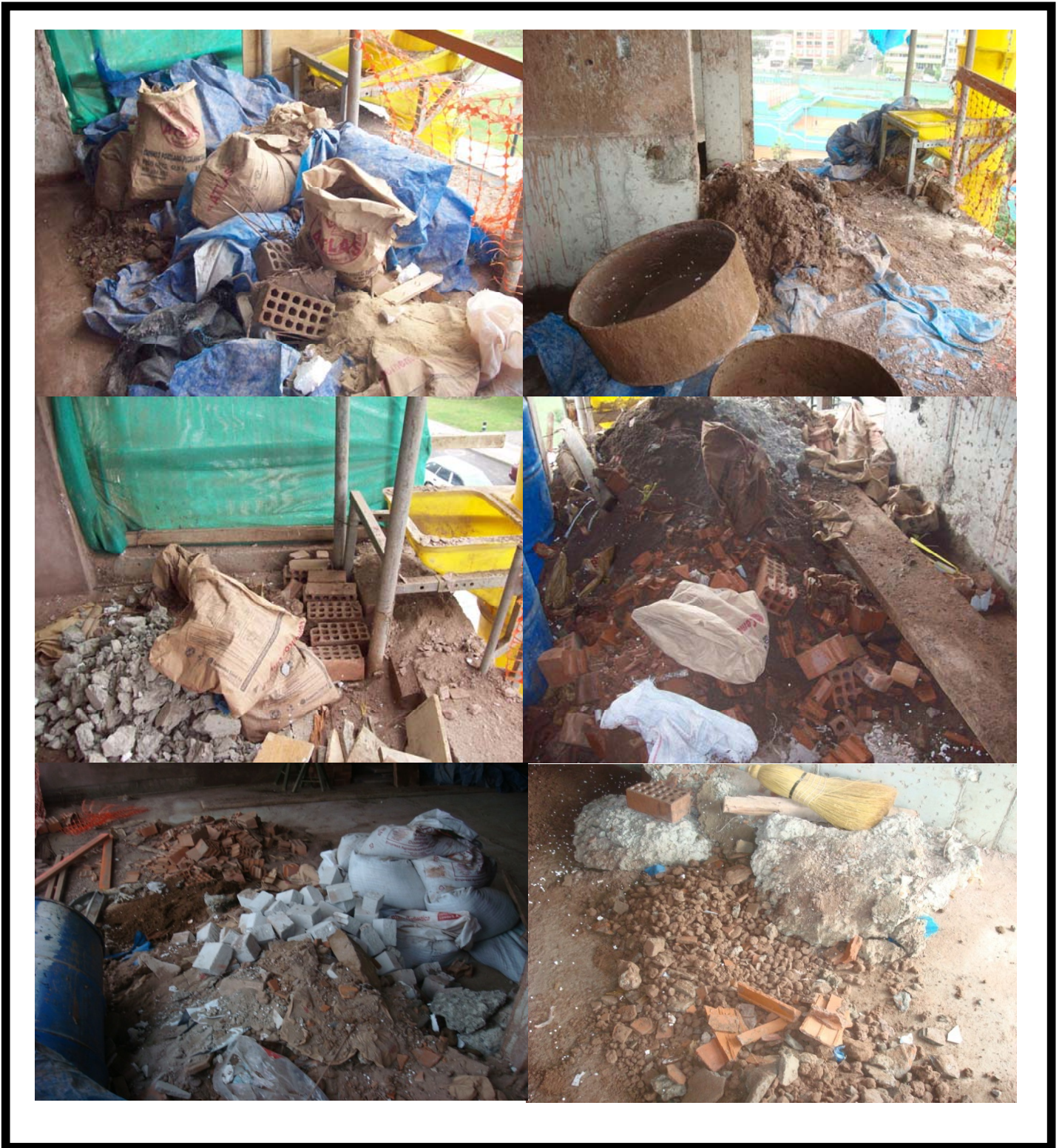
FOTO 1. Imágenes de residuos sólidos generados en Edificios "A" y "B"
