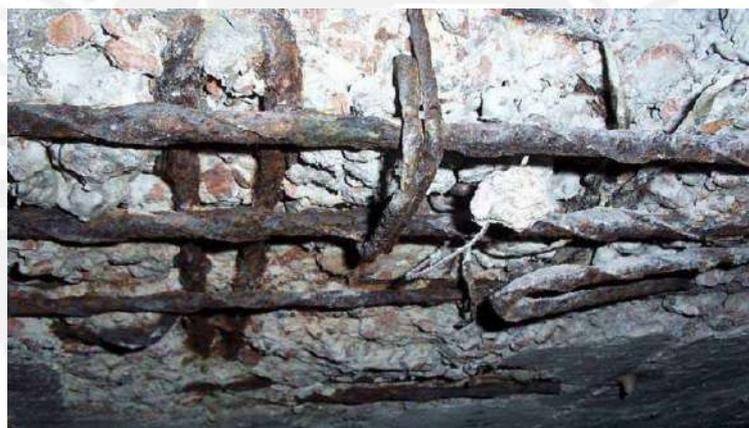
Figure 2.6: Daños por carbonatación del concreto (Ycaza, 2011)
