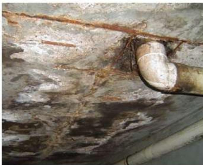
Figure 2.7: Daños por ácidos en alcantarillados (Ycaza, 2011)
