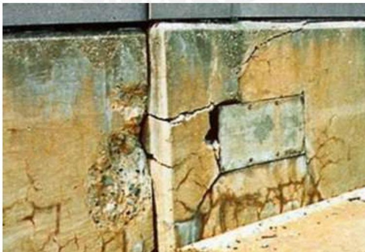
Figure 2.8: Daños por reacción álcali-agregado en muro (Pasquel, 1996).
