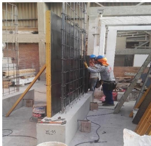
Figura 4.2.27: Técnica de reparación para estado de daño leve [18].
