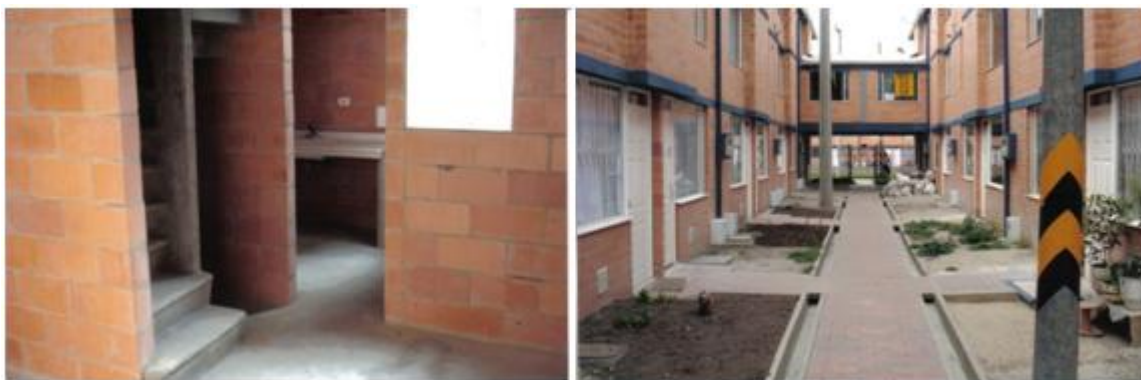
Figura 18. Viviendas de terminación mínima – Colombia.
