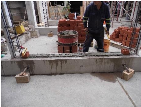
b) Ladrillos maestros y construcción de la primera hilada.
