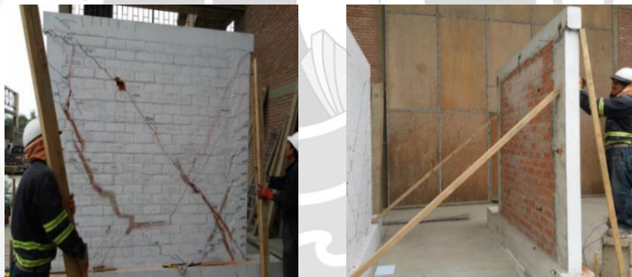
Figura 7.1 - Apuntalamiento del muro.
