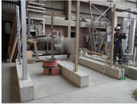
a) Habilitación de acero y encofrado en confinamiento vertical.
