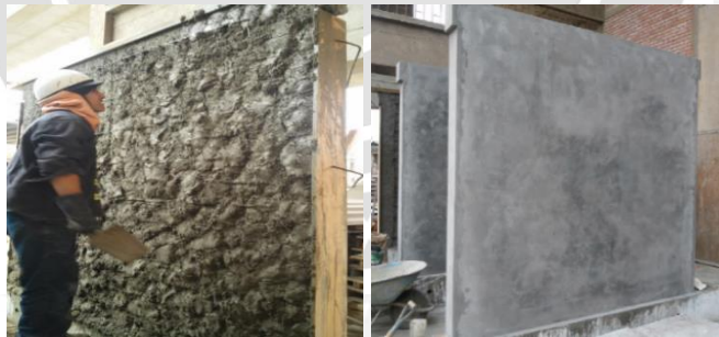
Figura 7.14 - Tarrajeo del muro con mortero 1:4 y acabado final del muro reforzado
