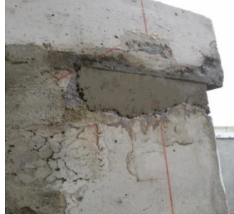
Figura 7.3 - Resane de esquinas superiores de elementos de confinamiento (vertical y horizontal).
