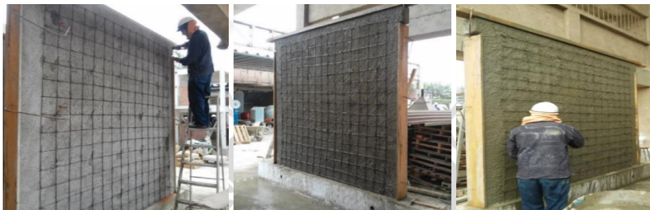
Figura 7.13 - Colocación y ajuste de guías y aplicación de lechada de mortero
