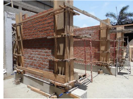
a) Habilitación de acero y encofrado en confinamiento vertical.
