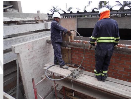
a) Habilitación de acero y encofrado en confinamiento vertical.
