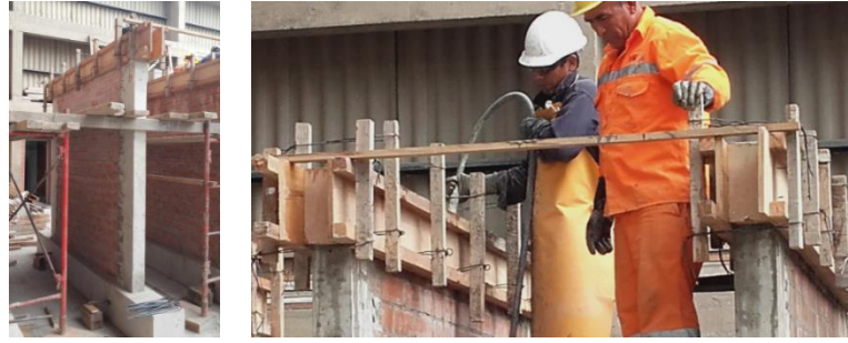
Figura 4.9 - Enconfrado del confinamiento horizontal. Proceso de vaciado y vibrado.
