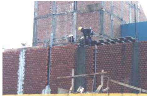
Figura 2.4 - Muro dividido en 2 partes
