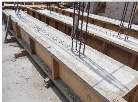
c) Alisado y rayado del concreto fresco. Curado del concreto.
