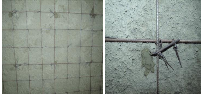
Figura 7.12 - Nudos taponeados (izq.) y detalle del taponeo (der.)
