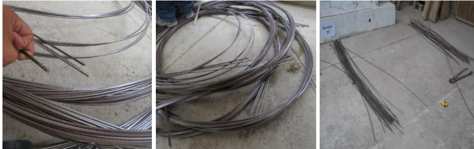
Figura 7.9 - Habilitación de rollos de alambre
