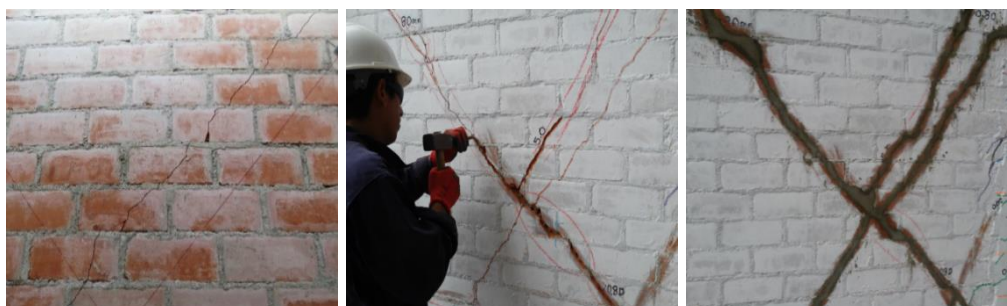
Figura 7.2 - Picado de muro a lo largo de grietas.
