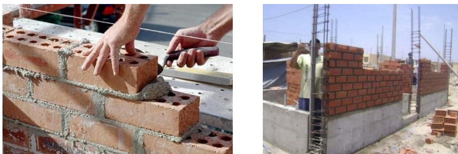
Figura 2.1 - Albañilería confinada
