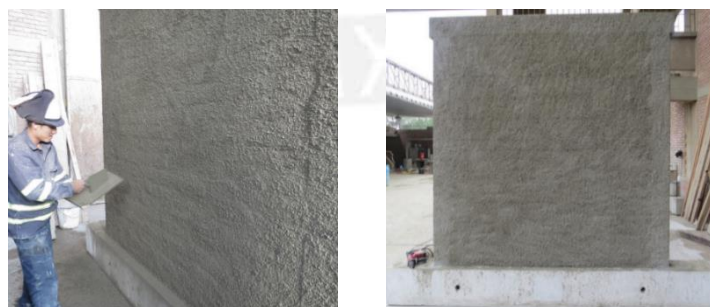
Figura 7.5 - Pañeteo del muro con mortero 1:4 (izq.) y muro después del pañeteo de 8mm (der.)
