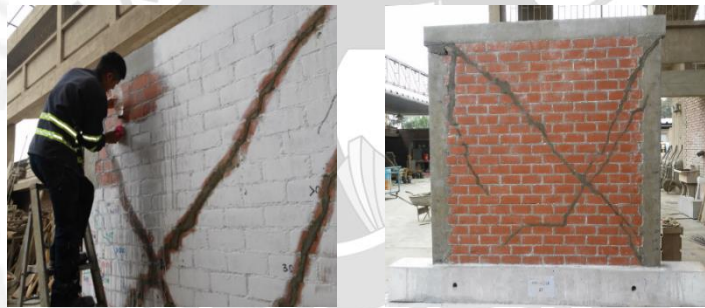
Figura 7.4 - Limpieza superficial de muros y muro.
