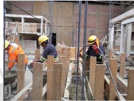
b) Ubicación de dados de concreto, puntos de izaje y vaciado de concreto.
