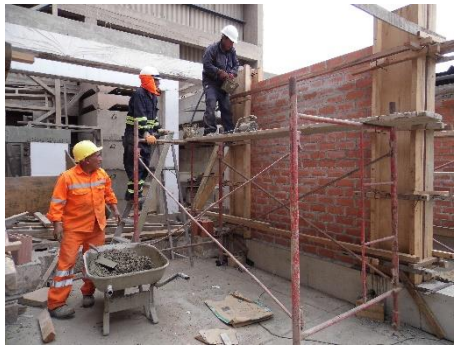
b) Vaciado y vibrado del confinamiento vertical.
