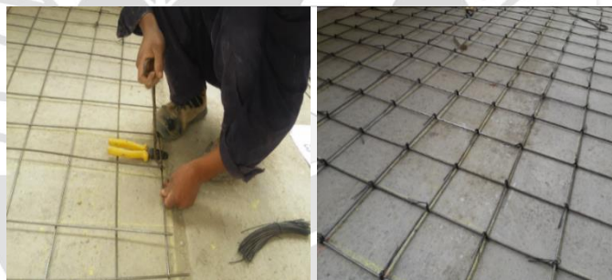
Figura 7.10 - Unión de varillas y su distribución final
