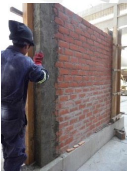
c) Desencofrado y curado del confinamiento vertical.
