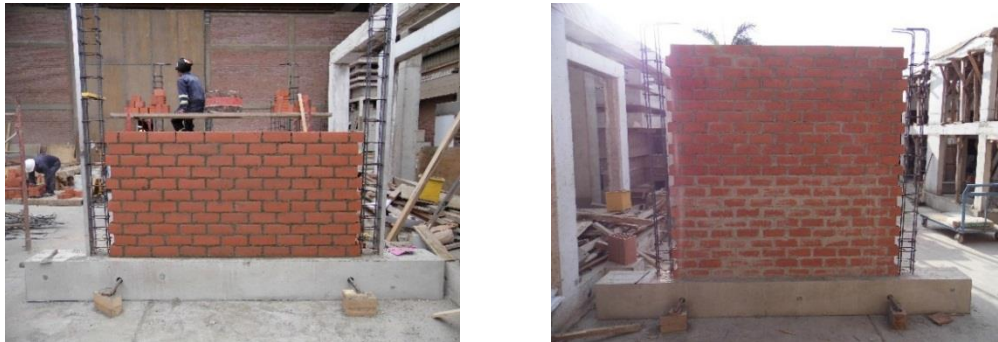
Figura 4.6 - Construcción de muros en primera y segunda etapa.
