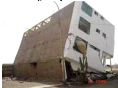
Figura 2.3 - Escasa densidad de muros
