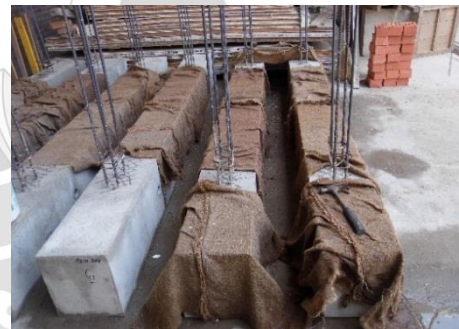
c) Alisado y rayado del concreto fresco. Curado del concreto.
