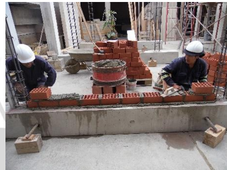
b) Ladrillos maestros y construcción de la primera hilada.
