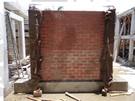
c) Desencofrado y curado del confinamiento vertical.
