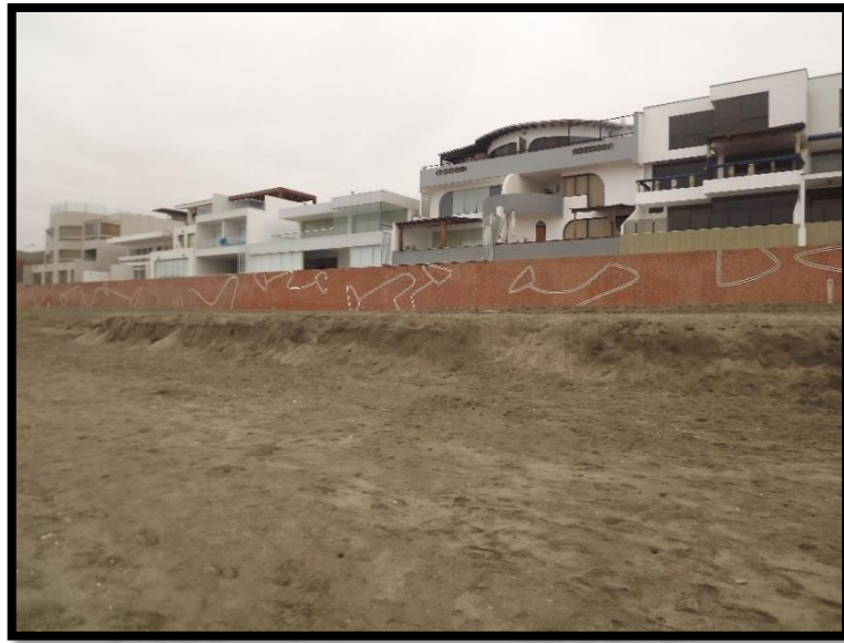
Figura 30: Escarpe de erosión.
