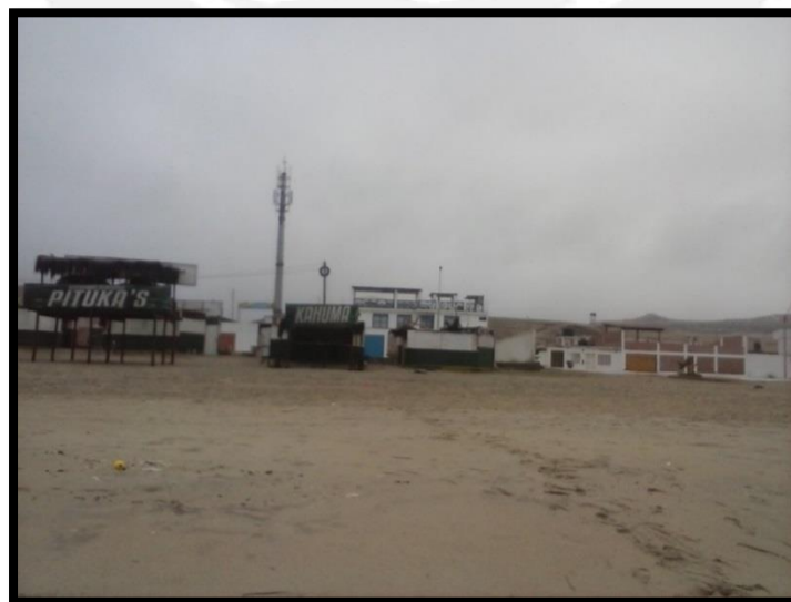
Figura 21: Viviendas alejadas de la línea de costa.
