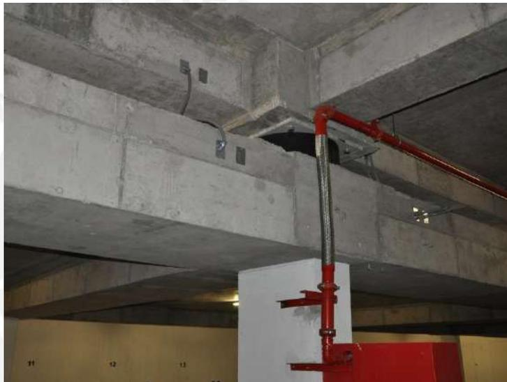
Figura 3.9: Conexiones flexibles de tuberías en la interfaz de aislamiento
