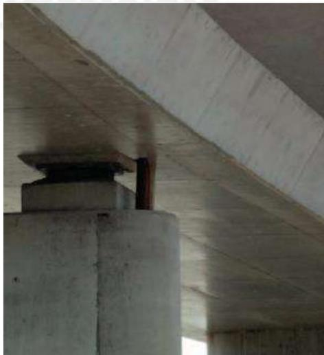
Figura 4.1: Apoyos VASOFLON® en puente tipo viga
