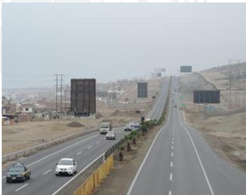
**Figura 2:** Pavimento flexible en un tramo de la PS4 (Carpeta asfáltica).
