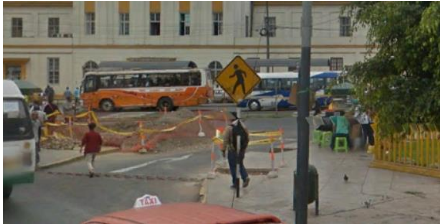
Figura 4.21 Señales de tránsito en la Av. 28 de Julio
