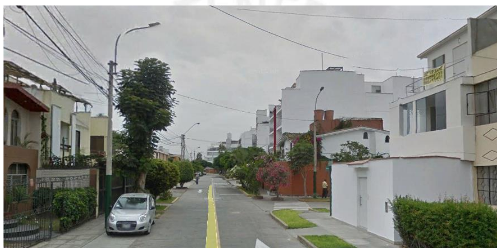
Figura 32: Calle Manuel Augusto Olayochea, Surco. Pertenece a la Zona A.
