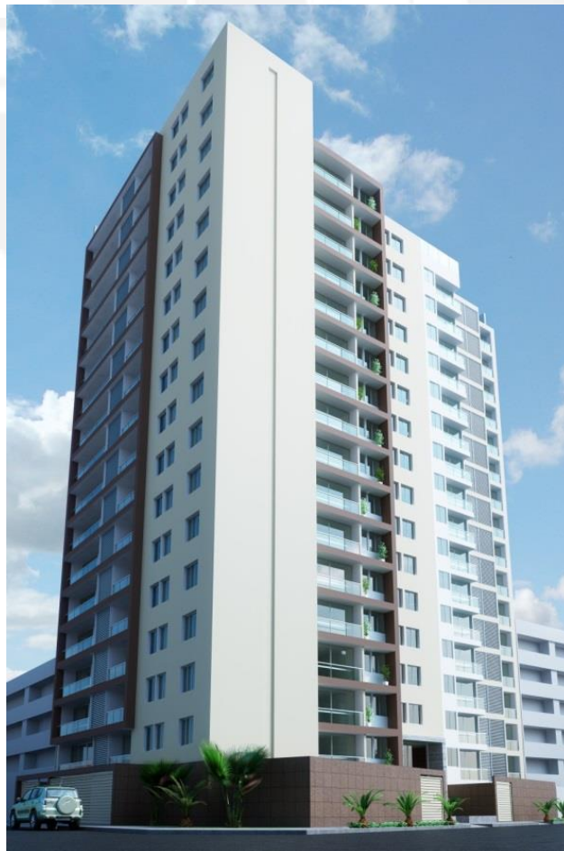
Figura 92: Elevación lateral del edificio.
