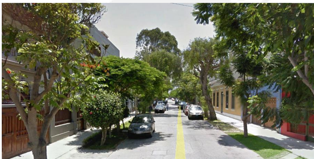
Figura 41: Jr. Centenario, Barranco. Perteneciente a la Zona E.
