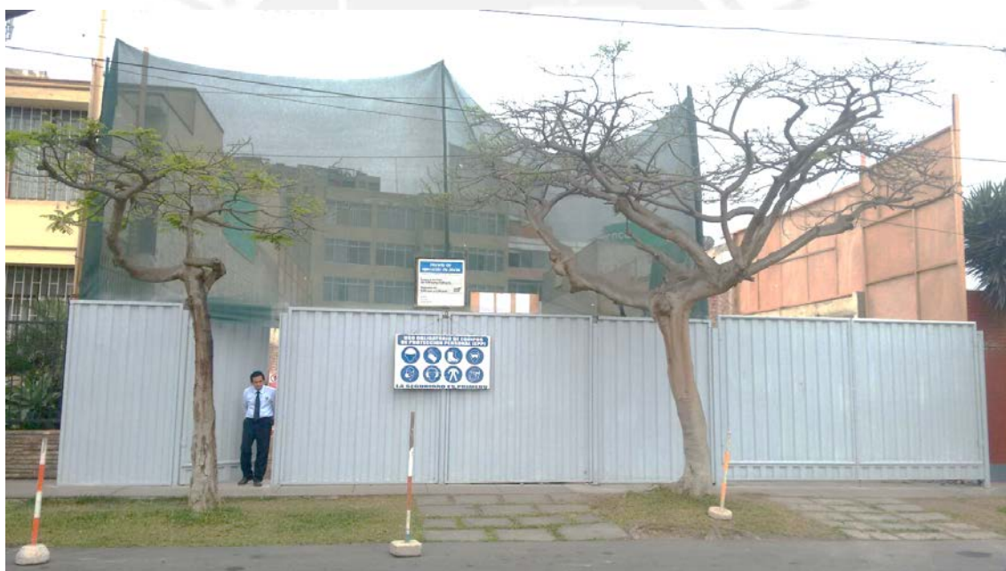
Foto de fachada. Inicio de obra: excavaciones de sótanos
