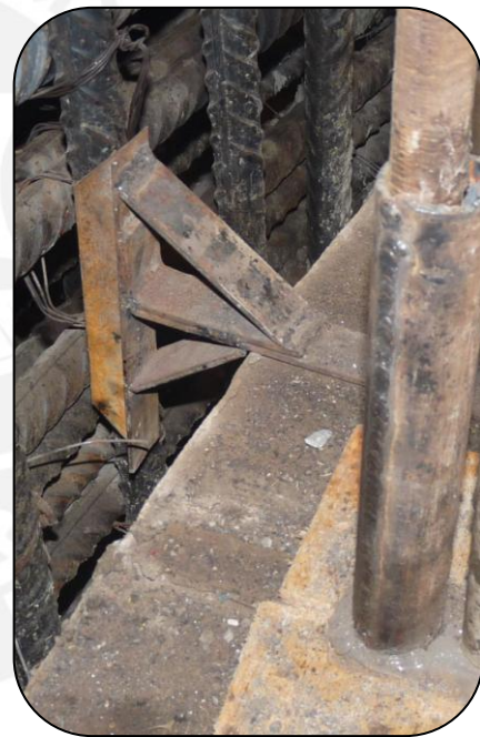
Fig. 2.27 Dispositivo para control de recubrimiento del acero.
