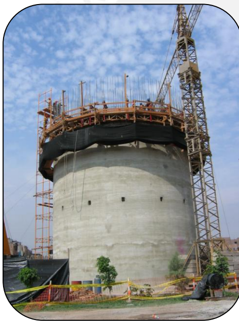
Fig. 4.3 Fuste para Reservorio Elevado.
