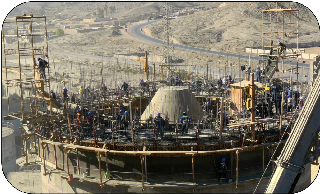
Fig. 2.1. Sistema de encofrados deslizantes-Silo de 10,000 TN-Yura-Arequipa.
