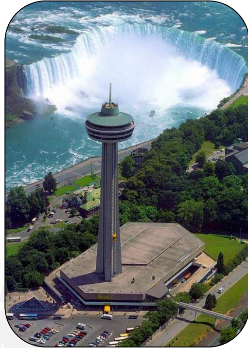
Fig. 4.12 Torre panorámica en las cataratas del Niágara.
