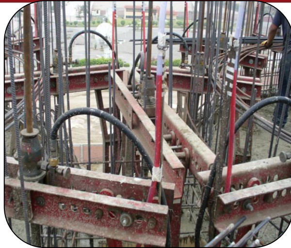
Fig. 2.16 Gatos conectados con mangueras de presión y su control de nivel horizontal.
