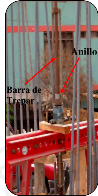
Fig. 2.22 Barras de trepar con anillo de bloqueo
