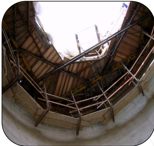
Fig. 2.8 Plataforma superior y andamios colgantes interiores
