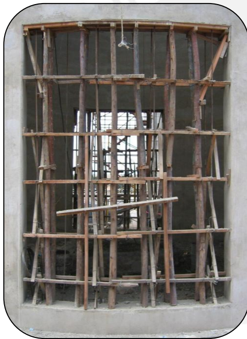
Fig. 2.26 Barras de trepar cruzando un vano, debidamente arriostradas.
