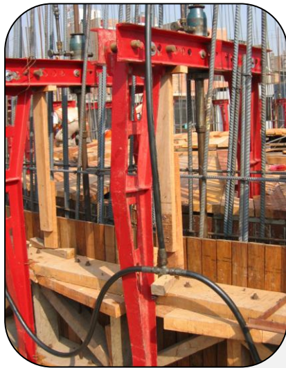
Fig. 2.6 Yugo metálico Concreto-Prometo.
