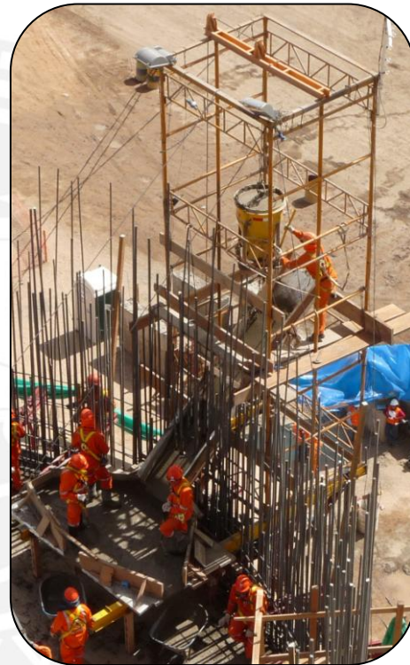
Fig. 2.29 Plataforma para elevación de concreto.
