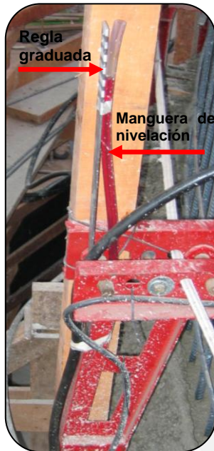
Fig. 2.23 Control de nivel horizontal.
