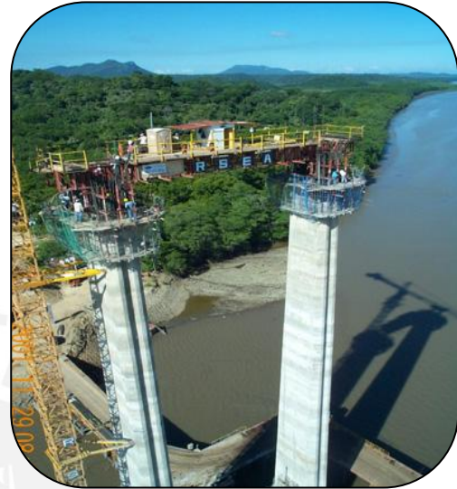
Fig. 4.6 Pilares de Puente-Costa Rica
