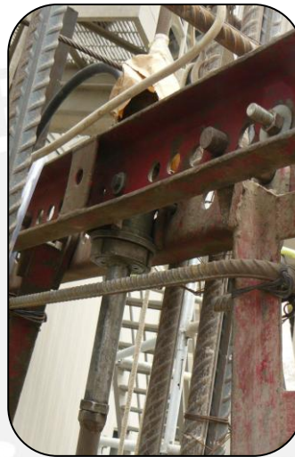
Fig. 2.11 Guía para hierro vertical fijada al yugo.
