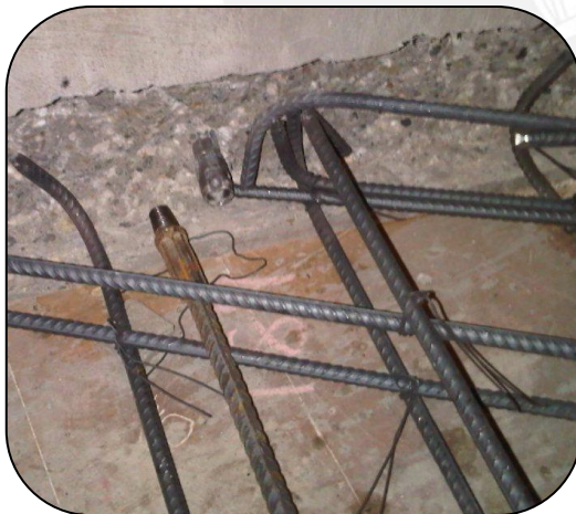
Fig. 6.1 Dowells con conectores mecánicos.
