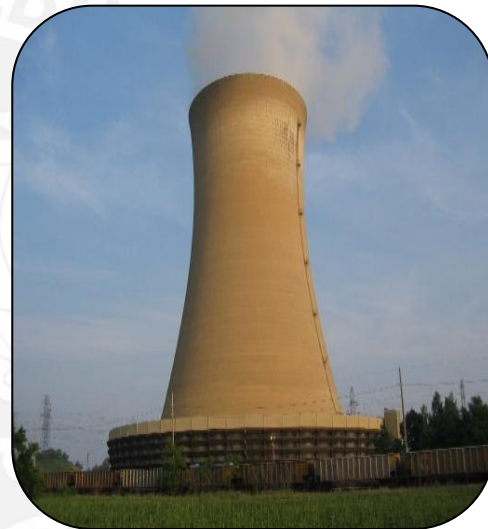
Fig. 4.2. Torre de enfriamiento.
