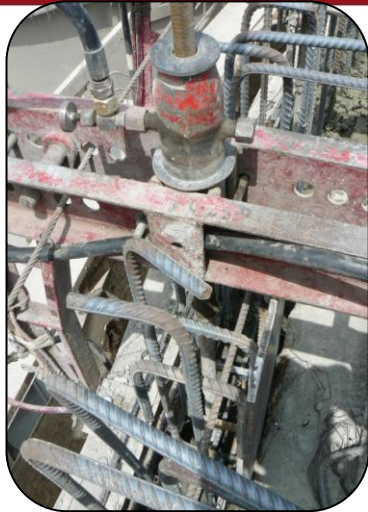
Fig. 2.15 Gato hidráulico armado sobre yugo
