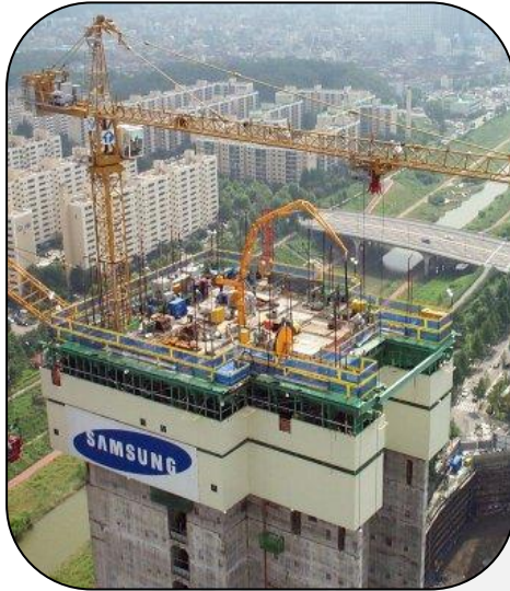
Fig. 4.5 Edificio de departamentos
