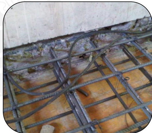
Fig. 6.2 Barras de acero en espera.
