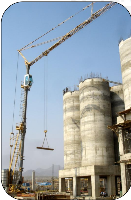
Fig. 2.30 Grúa Potain izando paquete de acero habilitado.
