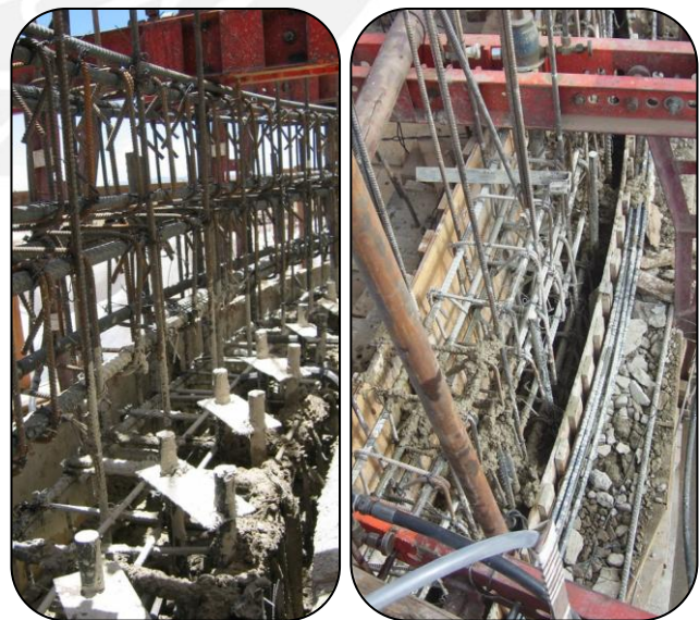
Fig. 4.14. Cambio de sección escalonada en silo-Juliana.
