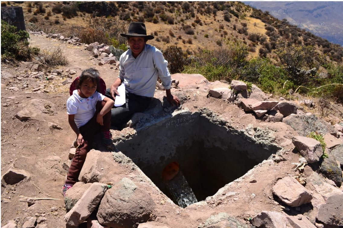
Foto 14. Don Natolio Ávila Sanchez junto a su hija menor en la caja de repartición de Santinpucllo (canal de Willcapampa), desde donde se distribuye el agua a la comunidad de Santiago de Tuna. Foto de la autora.
