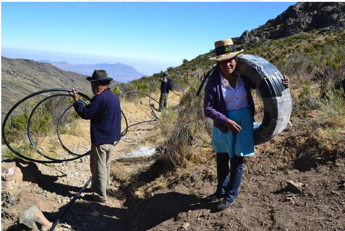
Foto 10. Autoridades comunales en la faena de instalación de tubos para el riego de pinos en la zona de Shogue, el 4 de agosto de 2015. Foto de la autora.
