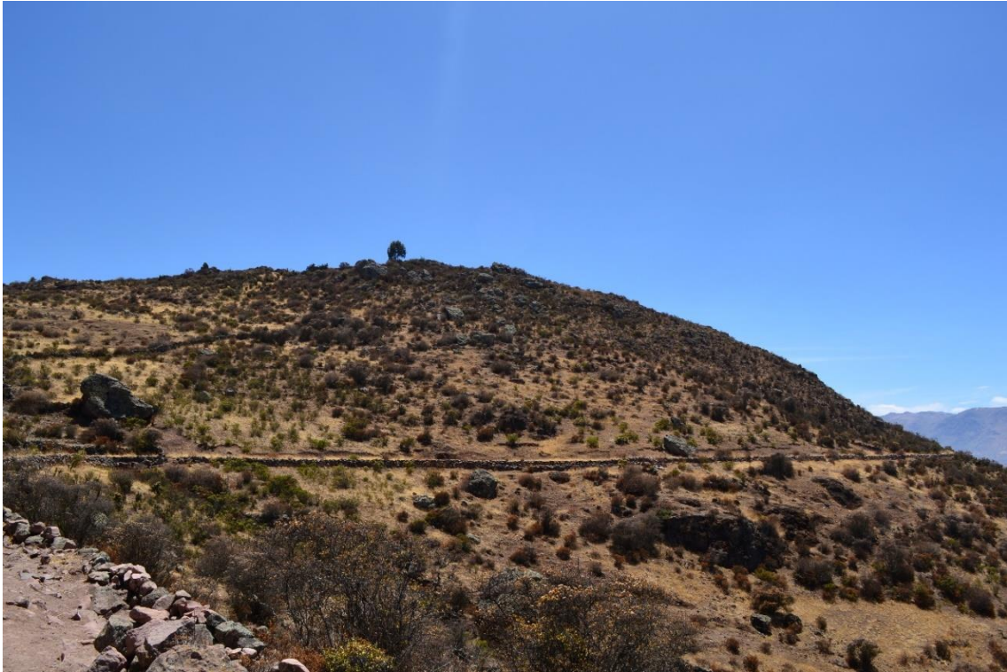
Foto 13. Vista del canal de Willcapampa. El entubado ha sido recubierto con tierra y piedras. Foto de la autora.
