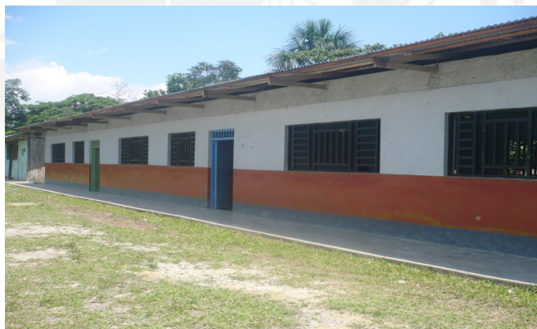
Aulas de Iero "A" y "B". Fuente: Foto propia
