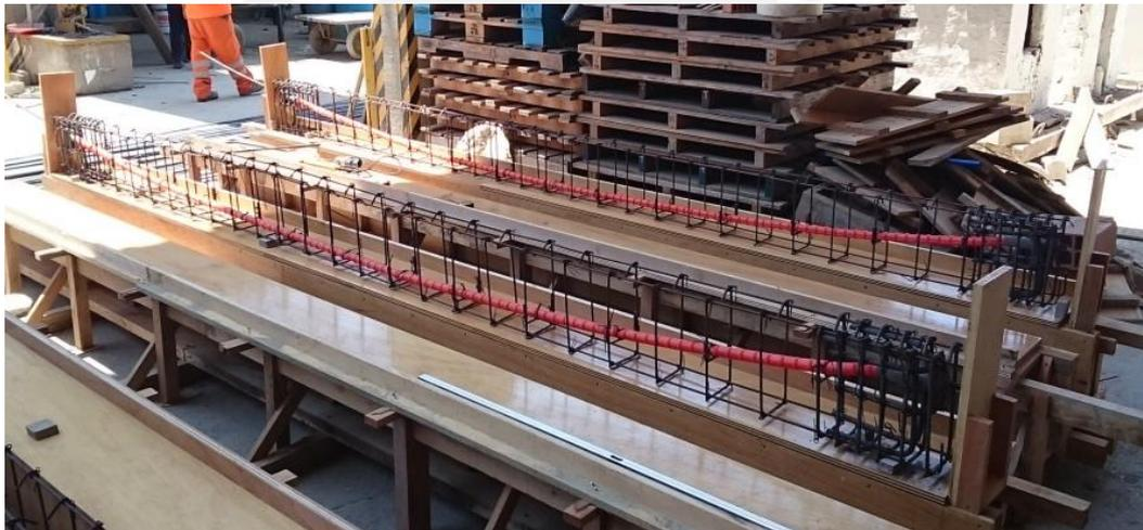
Fig. 5.3 Trayectoria parabólica del tendón en vigas con el tendón adherido
