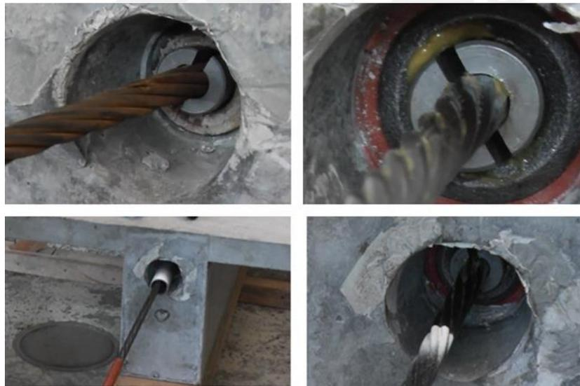
Fig. 5.5 Colocación de cuñas en vigas con el tendón adherido (izquierda) y no adherido (derecha) y pintado en el tendón para medir alargamiento final (parte inferior)
