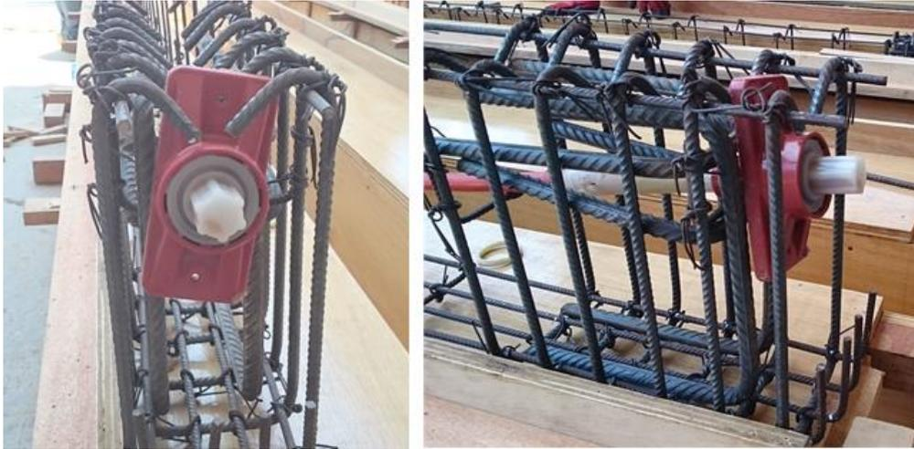
Fig. 5.2 Armadura y anclaje fijo en extremo de viga con tendón no adherido
