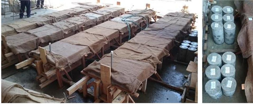
Fig. 5.4 Curado húmedo de vigas y probetas con manta de yute
