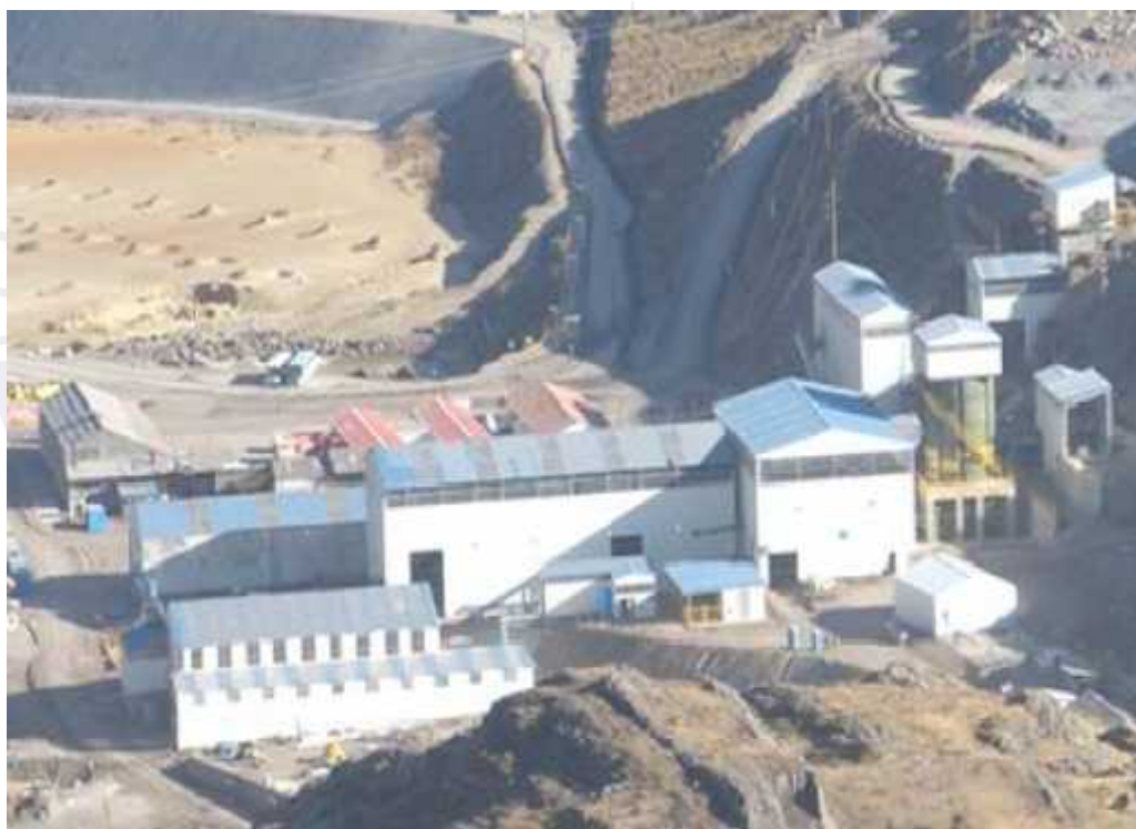
Figura 2. Construcción de Stock Pile de Mineral y Construcción de Deposito de Relaves para Tratamiento de Relaves y Mineral Fresco – Unidad Minera Trevali – Empresa Minera Los Quenuales.
