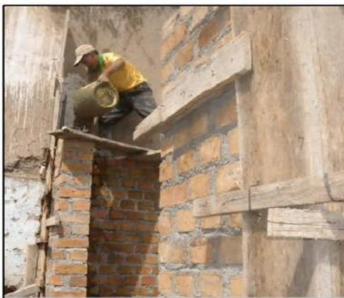
Fig. 7.35: No vibran al vaciar el concreto
