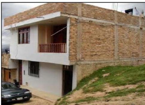
**Fig. 7.28:** Parapetos de azotea confinados sólo verticalmente.
