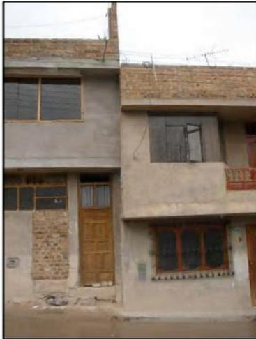
**Fig. 7.26:** Vano de puerta relleno de albañilería. Nótese además los desniveles entre losas colindantes y la falta de junta sísmica.
