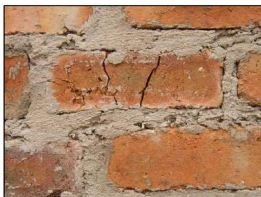
Fig. 7.42: Nótese resquebrajadura y variación en dimensiones.
