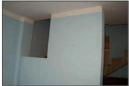
Fig. 7.20: Profusión de vanos en el sentido paralelo a la fachada.
