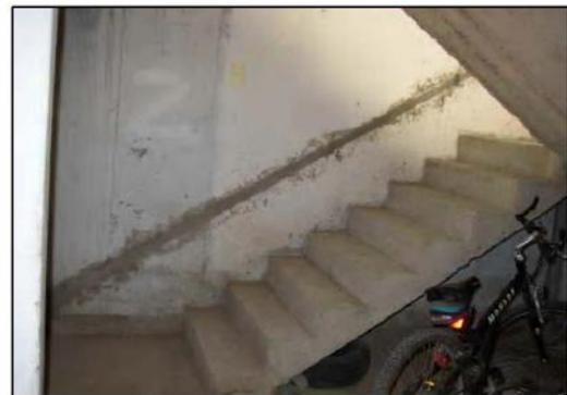
Fig. 7.18: Muro picado diagonalmente para el pase de tuberías de instalaciones eléctricas.
