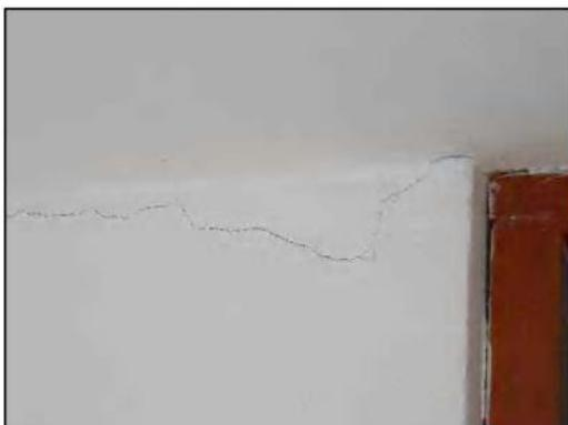
**Fig. 7.13:** Conectividad muro-aligerado eliminada.
