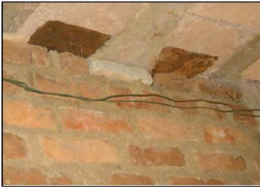
Fig. 7.19: Falta de conectividad muro-aligerado no existe transmisión de cargas.
