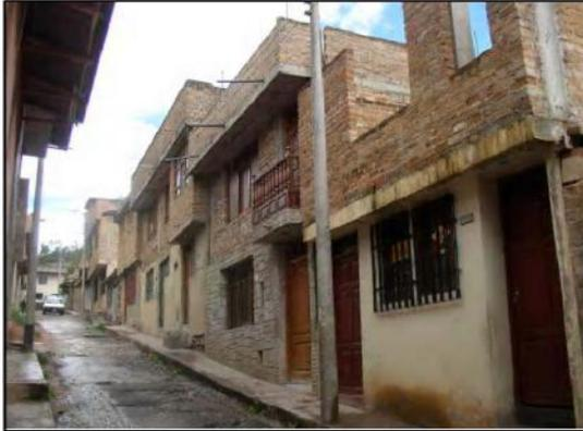
Fig. 7.22: La falta de junta sísmica se complica con los desniveles entre losas contiguas.
