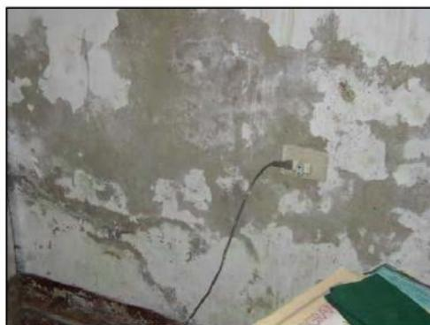
Fig. 7.2: Filtración de aguas (vivienda de la fotografía izquierda).
