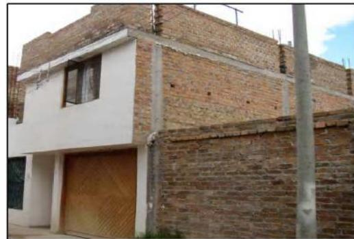
**Fig. 7.29:** Futuros confinamientos de parapetos en azotea.
