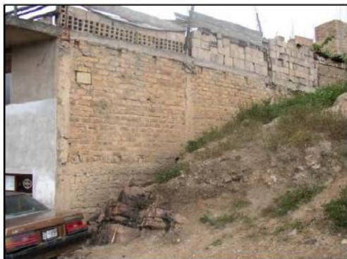
Fig. 7.1: No existe sistema de drenaje, y empuje lateral del terreno.
