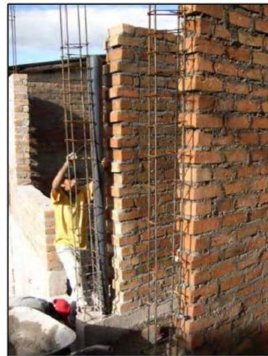
Fig. 7.36: Colocación de tubería de desagüe de 4", en la zona del endentado.
