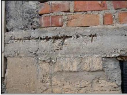
Fig. 7.37: Cangrejera en viga expone armadura a la intemperie.
