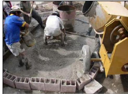
Fig. 7.34: Tienen mezcladora pero vacían la mezcla al piso, contaminándola.
