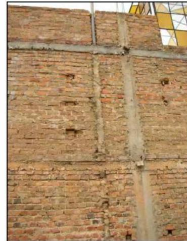
Fig. 7.16: Tuberías de desagüe, los muros no están reforzados adecuadamente.
