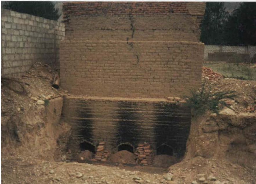
Fotografía N° 3.4: Parte Posterior del horno, se aprecia tres hogares y las tres partes diferenciadas del horno: inferior, intermedia y superior.
