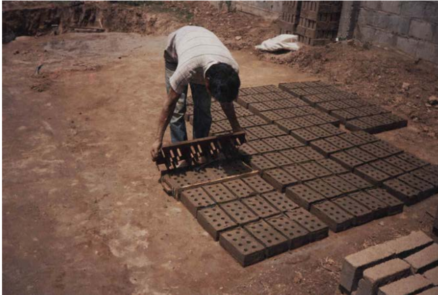
Fotografía N° 3.15: Moldeo de unidades y ubicación en tendal. Obsérvese que el desmolde se hace en dos etapas, primero se desprende el fondo con los vástagos y luego las paredes.
