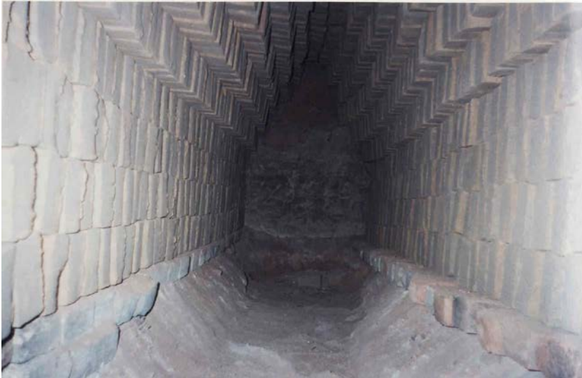
Fotografía N o 3.7: Vista interior de uno de los hogares, obsérvese la disposición de ladrillos formando una bóveda.
