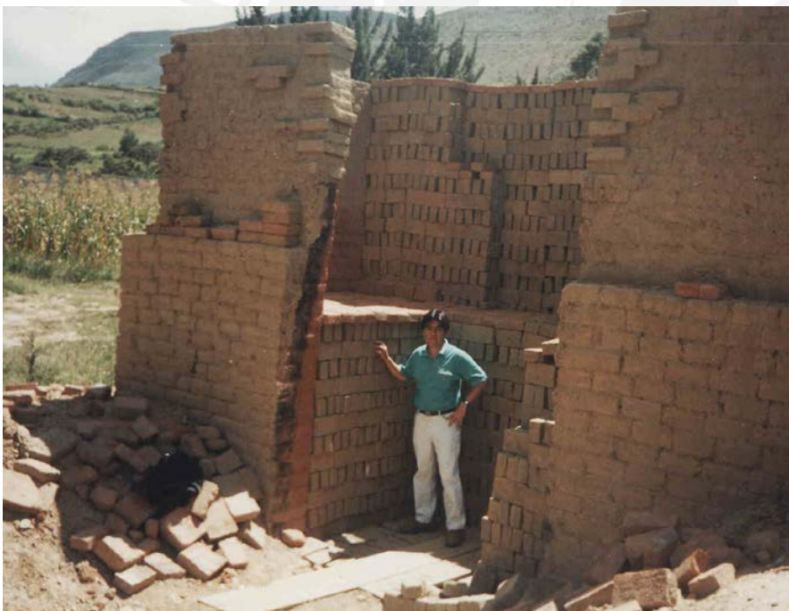
Fotografía N° 3.5: Parte delantera del horno, desde esta posición solo se observa la parte intermedia y superior y es por donde se efectúa el carguío.
