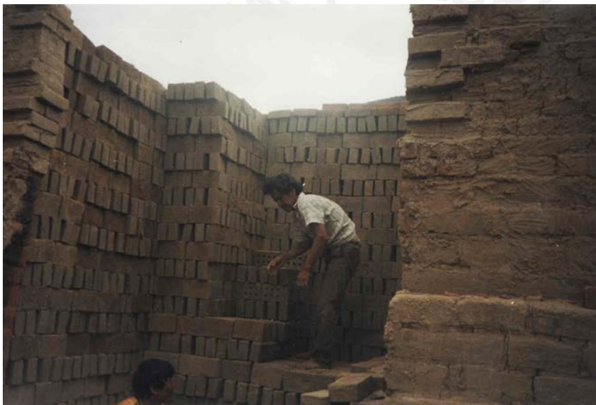
Fotografía N o 3.22: Disposición de ladrillos mejorados en la parte superior del horno (Lote 2)
