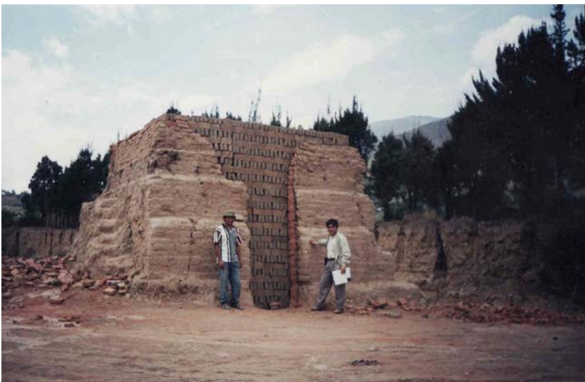
Fotografía N o 3.9: Puerta de carga del horno, obsérvese la separación de ladrillos para permitir la circulación del aire caliente.
