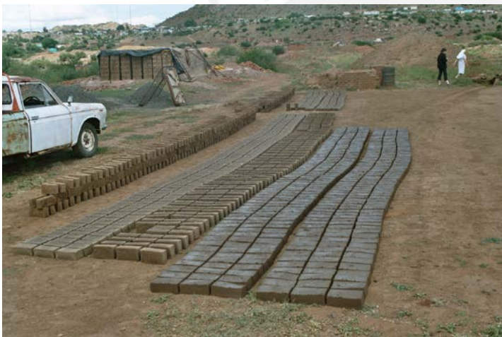
Fotografía N° 2.18: Ladrillos moldeados, luego de canto, finalmente en rumas con cubierta para completar el secado al aire libre ( http://aldoarqangel.blogspot.com ).
