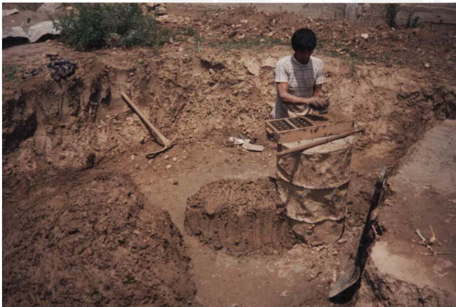
Fotografía N° 3.14: Crudo y moldeo de unidades mejoradas
