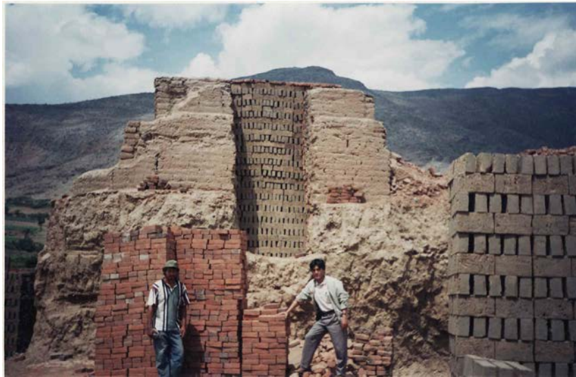
Fotografía N° 3.10: Puerta de descarga del horno, libre antes de iniciar el quemado.
