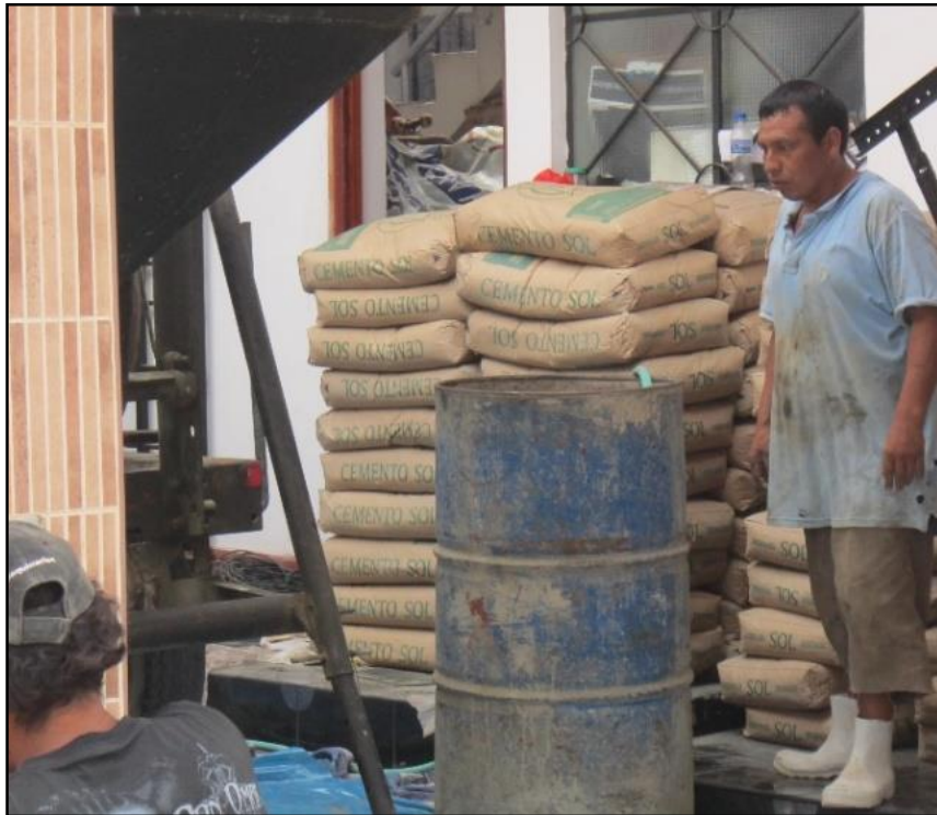
Obra 11 - Cabo Blanco
