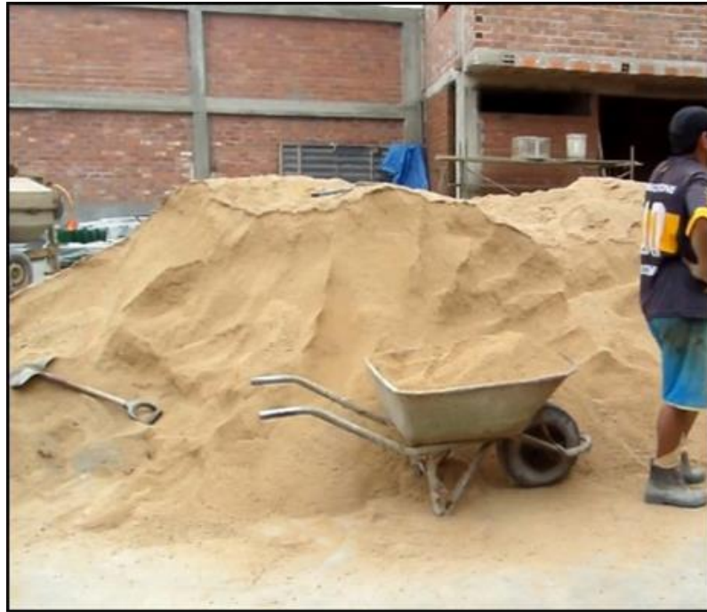
Obra 7 - Marqués de Corpac
