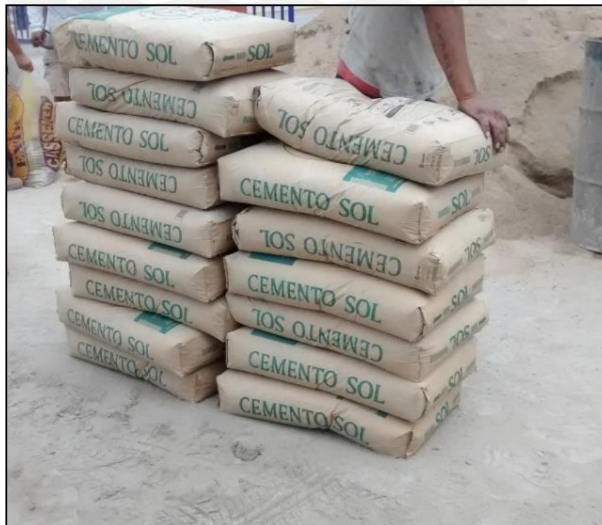
Obra 10 - Los Horizontes
