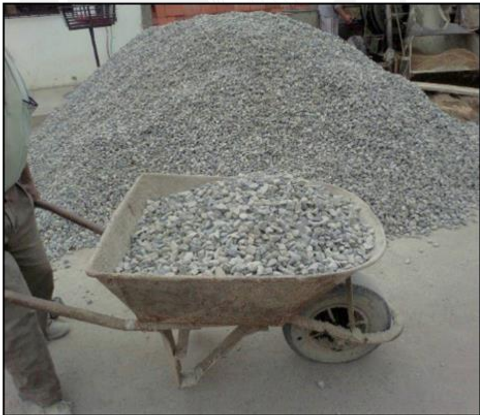
Obra 4 - Villa Nicolasa II
