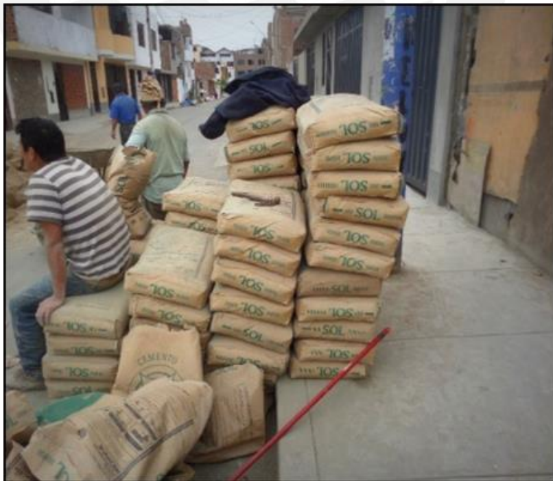
Obra 4 - Villa Nicolasa II
