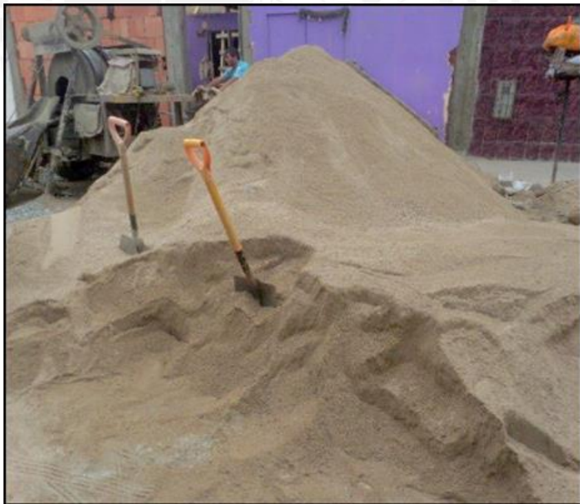
Obra 4 - Villa Nicolasa II
