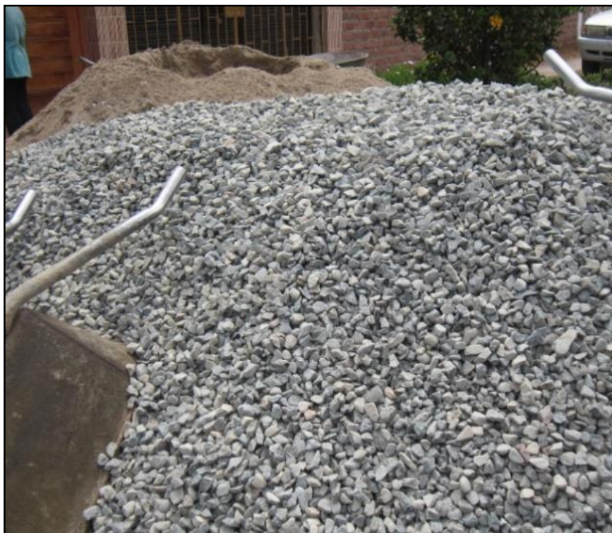
Obra 11 - Cabo Blanco
