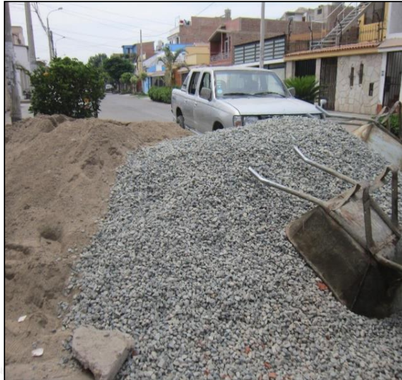
Obra 11 - Cabo Blanco
