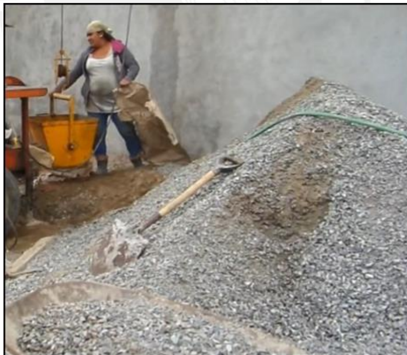
Obra 6 - Alameda Sur
