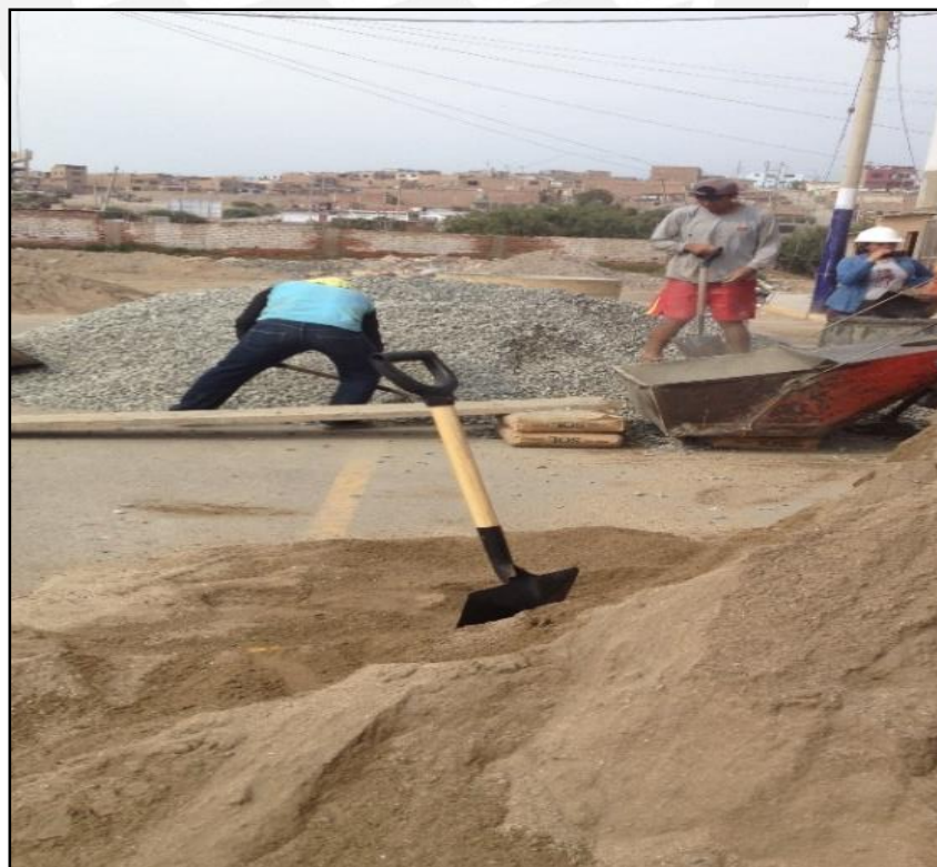
Obra 12 - Bello Horizonte
