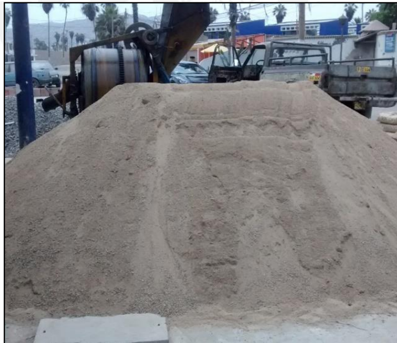
Obra 10 - Los Horizontes
