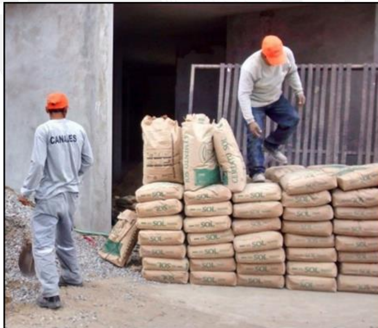
Obra 6 - Alameda Sur
