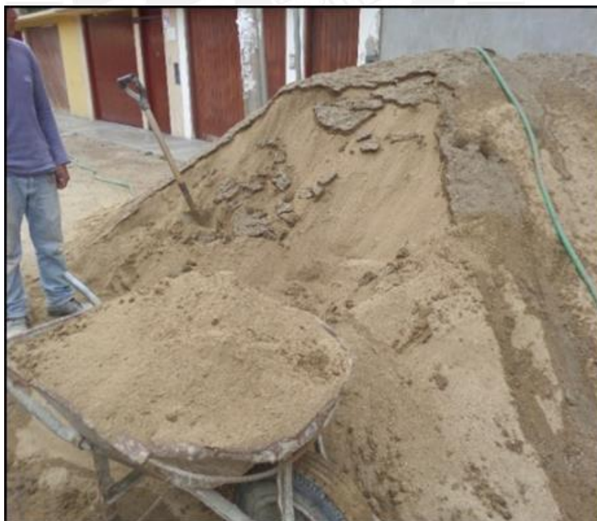
Obra 6 - Alameda Sur
