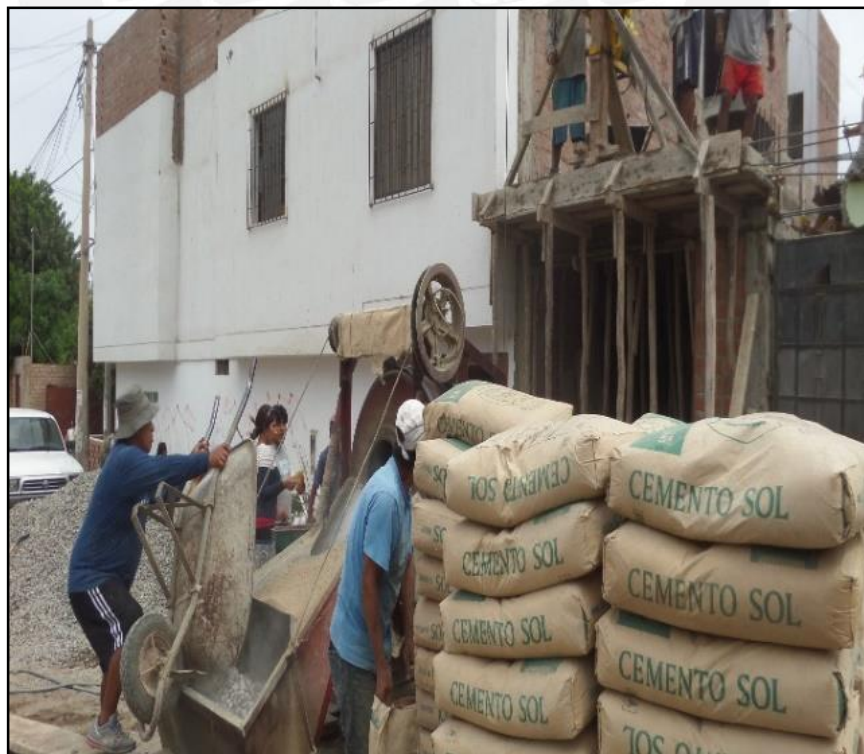
Obra 12 - Bello Horizonte
