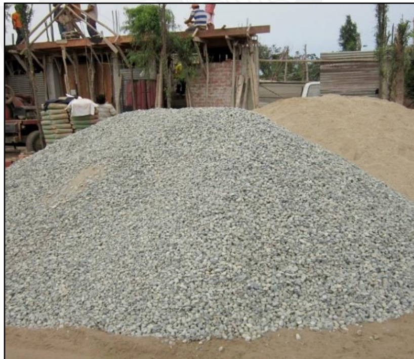
Obra 2 - Los Eucaliptos
