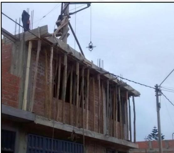
Figura 5.2, Encofrado de losa de techo
