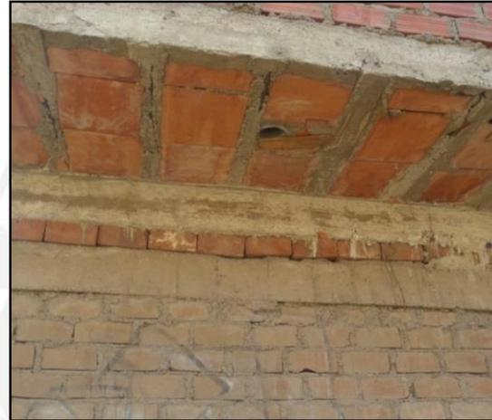
Figura 4.7, Hilera de ladrillos sobre viga solera
