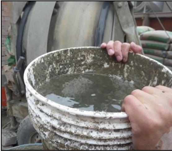
Figura 6.9, El agua se echaba a la mezcla con la ayuda de baldes de plástico
