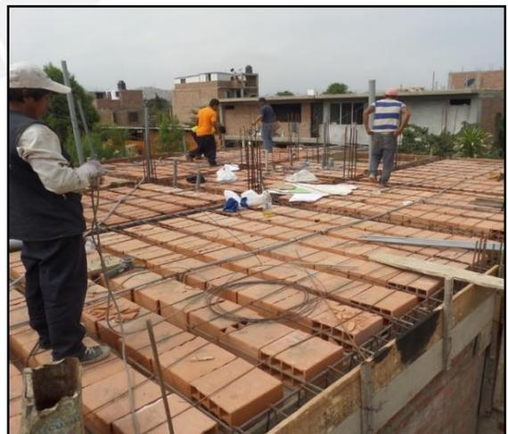
Figura 5.3, Armado de losa de techo
