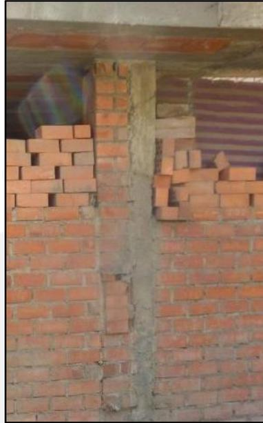
Figura 4.5, Columna de concreto y ladrillo
