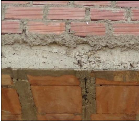
Figura 4.6, Formación de cangrejeras (Construcción defectuosa)
