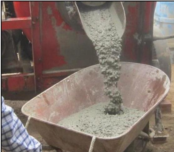
Figura 5.10, Concreto sin aditivo - Obra 4
