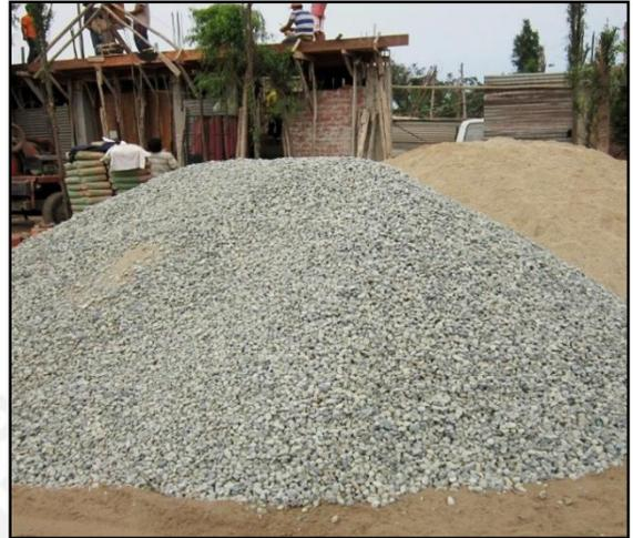
Figura 6.8, En la Obra 2 se observa que la piedra es mas uniforme
