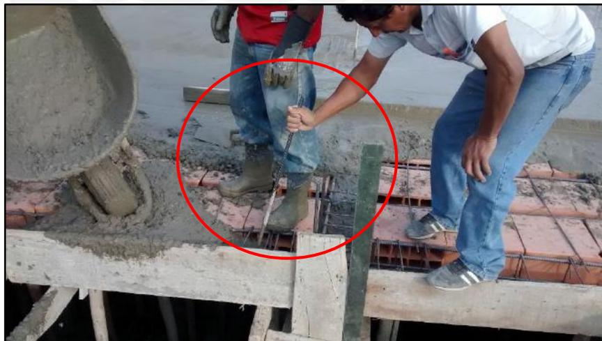
Figura 7.7, Uso de varilla corrugada para compactar el concreto fresco
