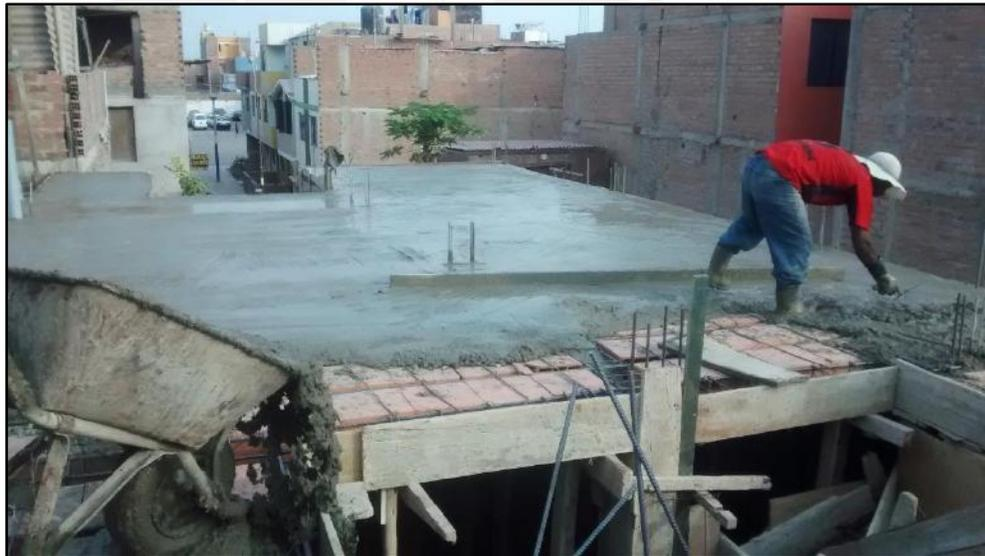
Figura 7.6, La colocación del concreto se realiza de los extremos hacia adelante
