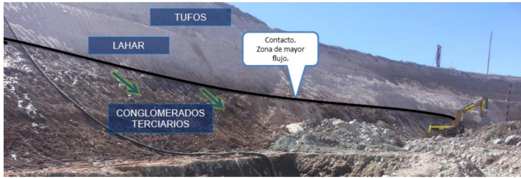
Figura 36 Zona de contacto entre conglomerados y tufos y lahares, zona de mayor flujo
