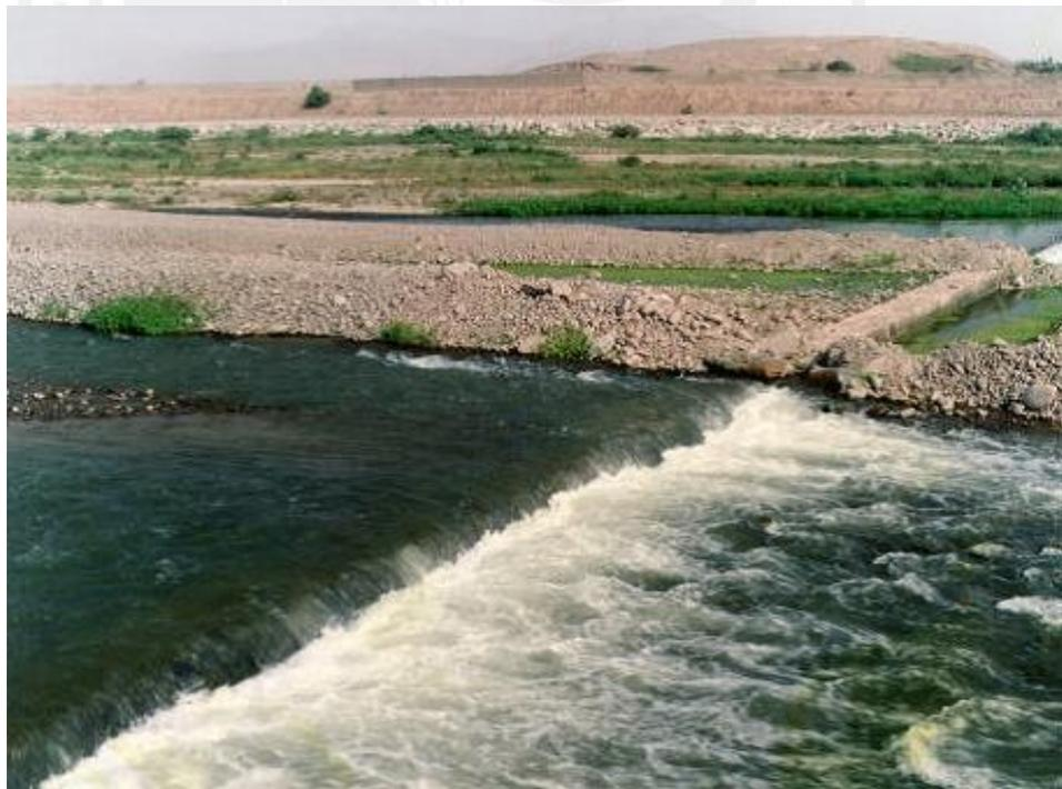
Figura 3.9: Vista Norte Sur de Pantallas pantallas transversales río Rímac. Fuente: Montenegro J. Recarga artificial de acuíferos, Lima 2013, <http://civilgeeks.com/2011/09/18/recarga-artificial-de-acuíferos/>
