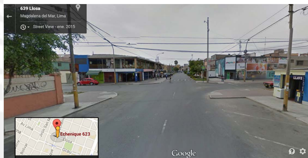
Ilustración 15: Vista desde Jr. Llosa con dirección Oeste. (Google Maps)
