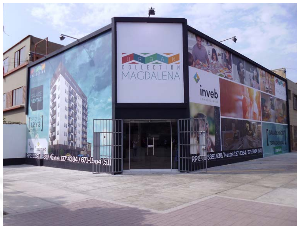
Ilustración 42: Fachada de la sala de ventas (Elaboración propia).
