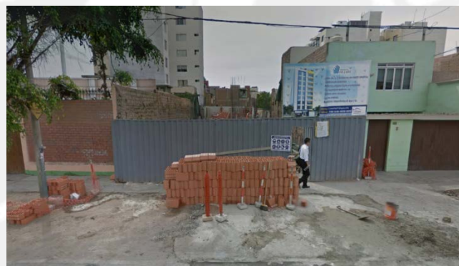
Ilustración 112: Cerco de obra (DKasa, 2015)
