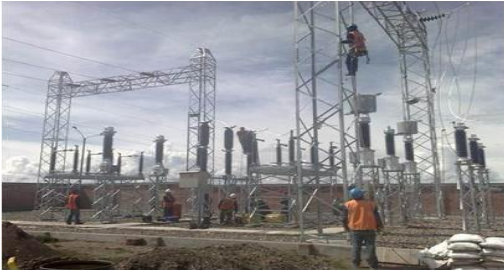
Figura 16. Montaje electromecánico en Puno. Tomado de “Proyectos,” por Ajani, 2015d, [Fotografía N° 17]. Recuperado de http://www.ajani.com.pe/proyectos/
