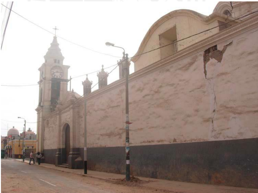
Fig. 17 - Muro de adobe lateral largo, lado norte [1]
