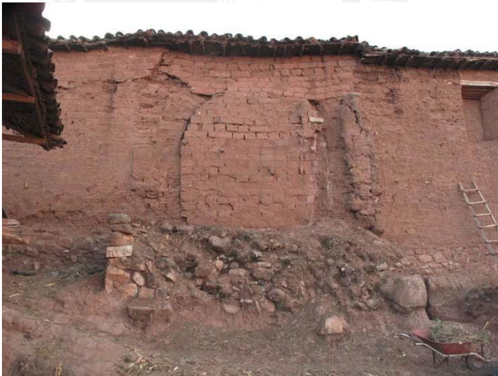
Fig. 36 – Muro lateral oeste de adobe [1]
