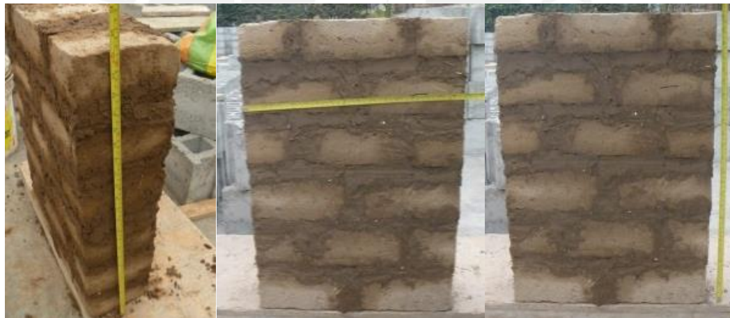
Fig. 50 - Construcción de los muretes de adobe (3)
