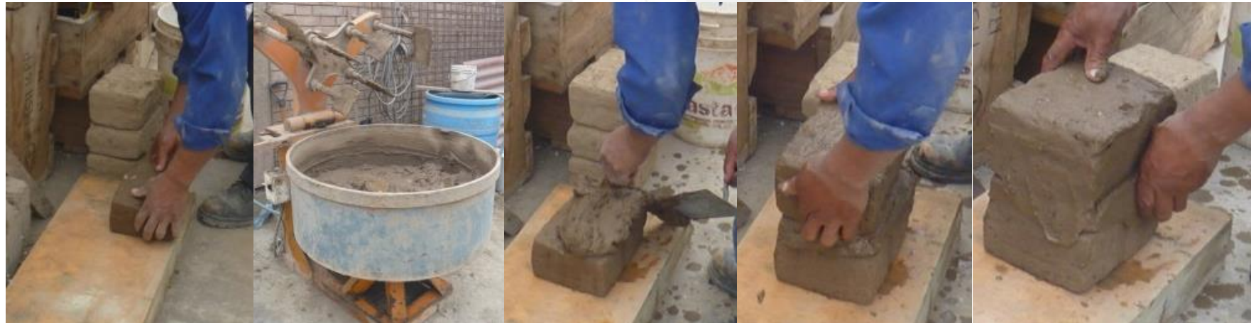
Fig. 43 - Construcción de las pilas de adobe (3)
