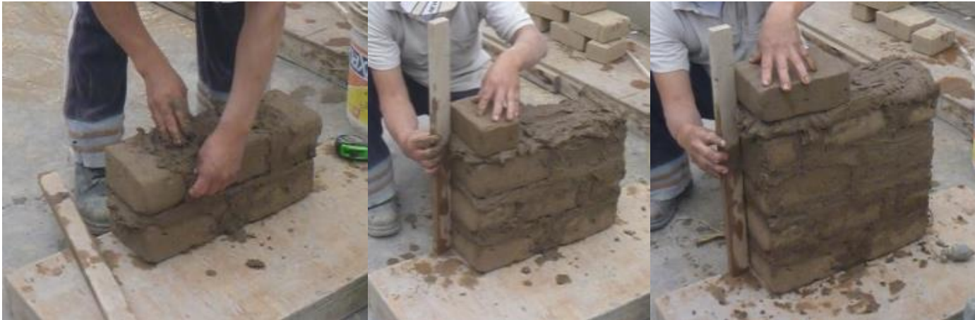
Fig. 49 - Construcción de los muretes de adobe (2)
