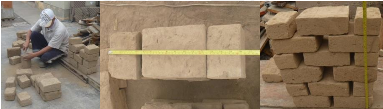
Fig. 48 – Construcción de los muretes de adobe (1)
