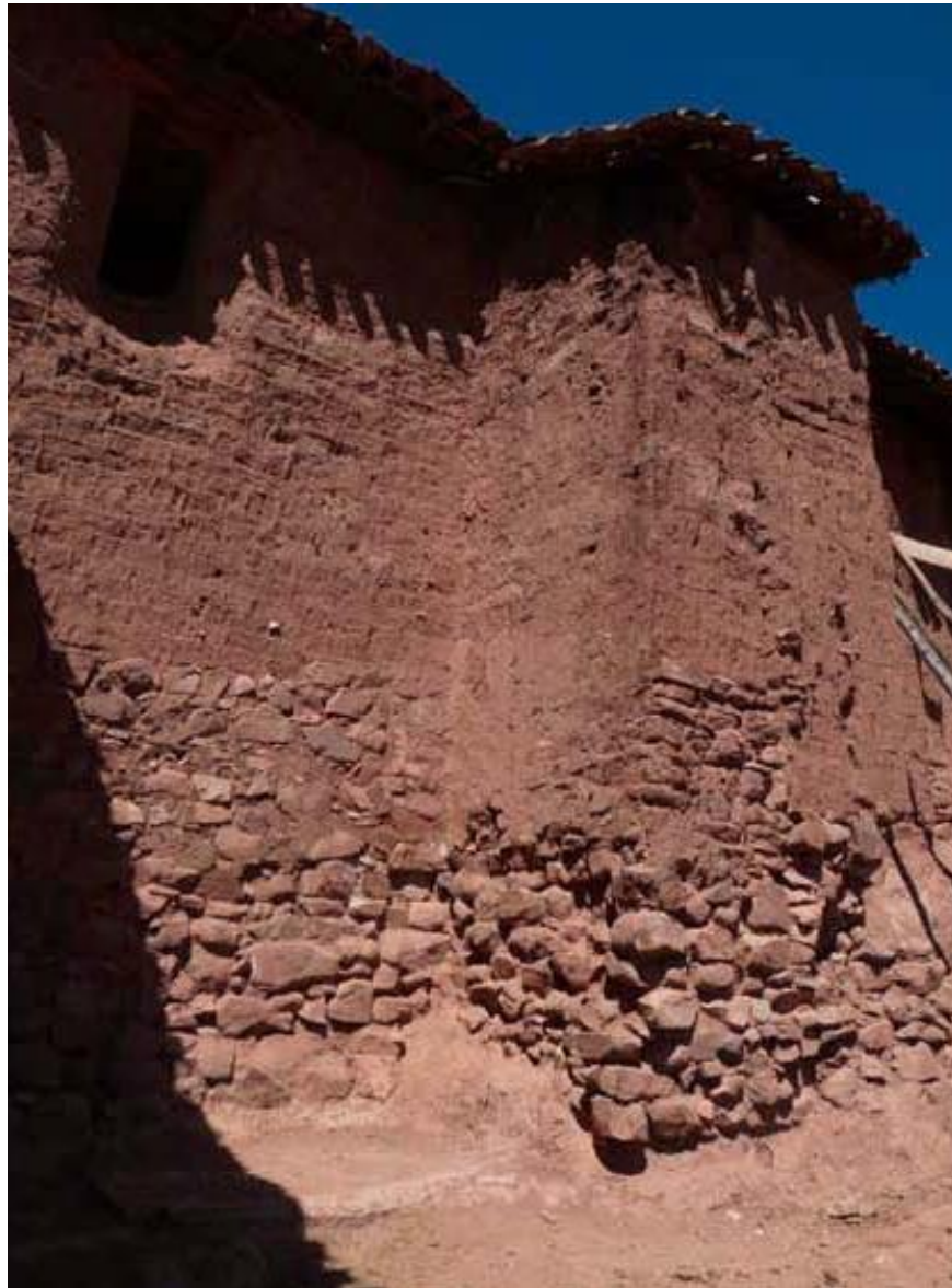
Fig. 23 - Afloramiento visible de roca en el lado este de la Iglesia [1]
