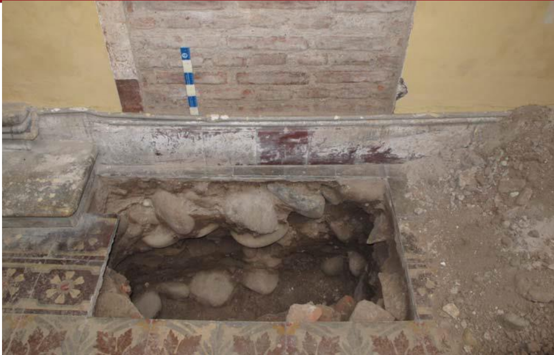
Fig. 8 – Composición de la cimentación y sobrecimiento [1]
