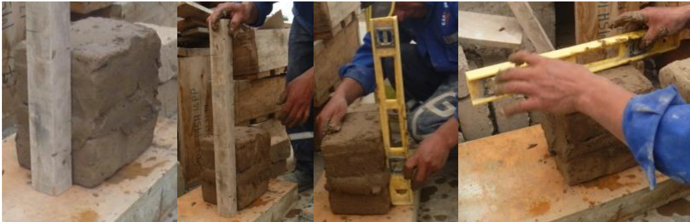
Fig. 44 - Construcción de las pilas de adobe (5)
