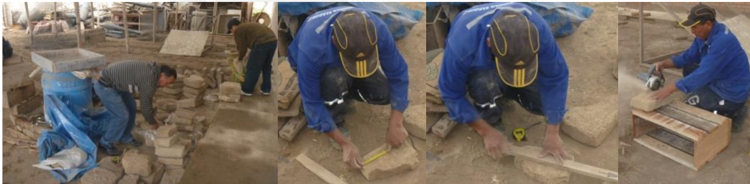
Fig. 41 - Construcción de las pilas de adobe (1)
