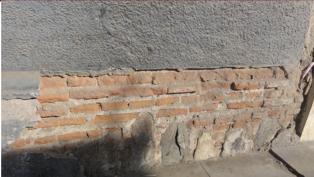
Fig. 18 - Sobrecimiento de ladrillo de la pared lateral de lado norte [L. Vargas]
