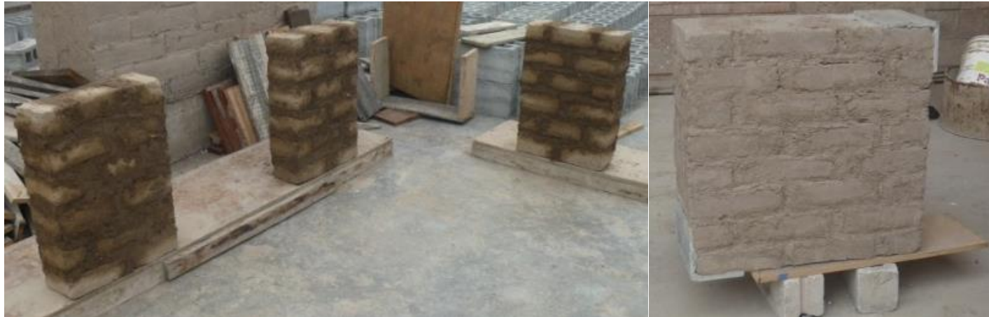
Fig. 51 – Construcción de los muretes de adobe (4)
