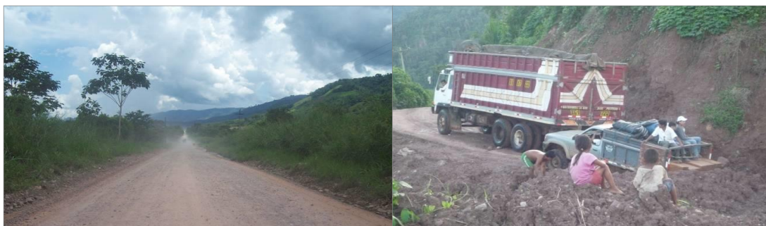
Figura 2: Carretera con pavimento afirmado
