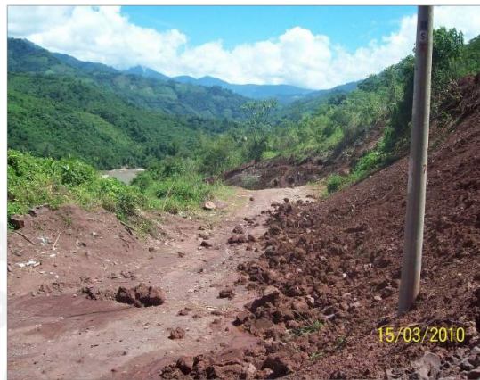
Figura 3: Carretera afectada por las lluvias
