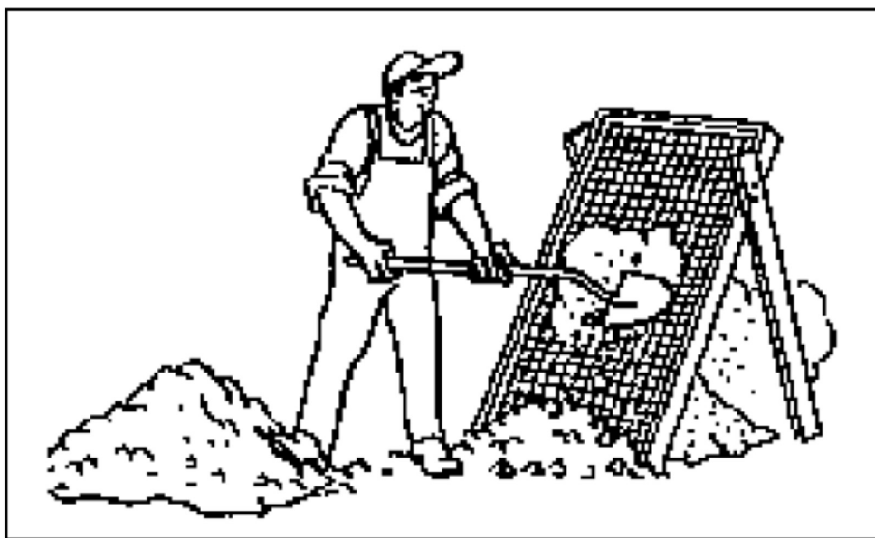
Figura 2.1 Tamizado manual (Guillaud et al. 1995)
