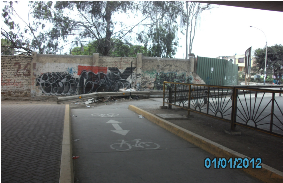
ANEXO 02.- Ciclovía Av. Universitaria ocupa parte de dicha arteria lo separa una división de concreto, el ancho es reducido y carece de mantenimiento.- Ciclovía a inmediaciones de la Universidad de San Marcos ha sido improvisada debajo de un puente Av. Venezuela(23NOV14)
