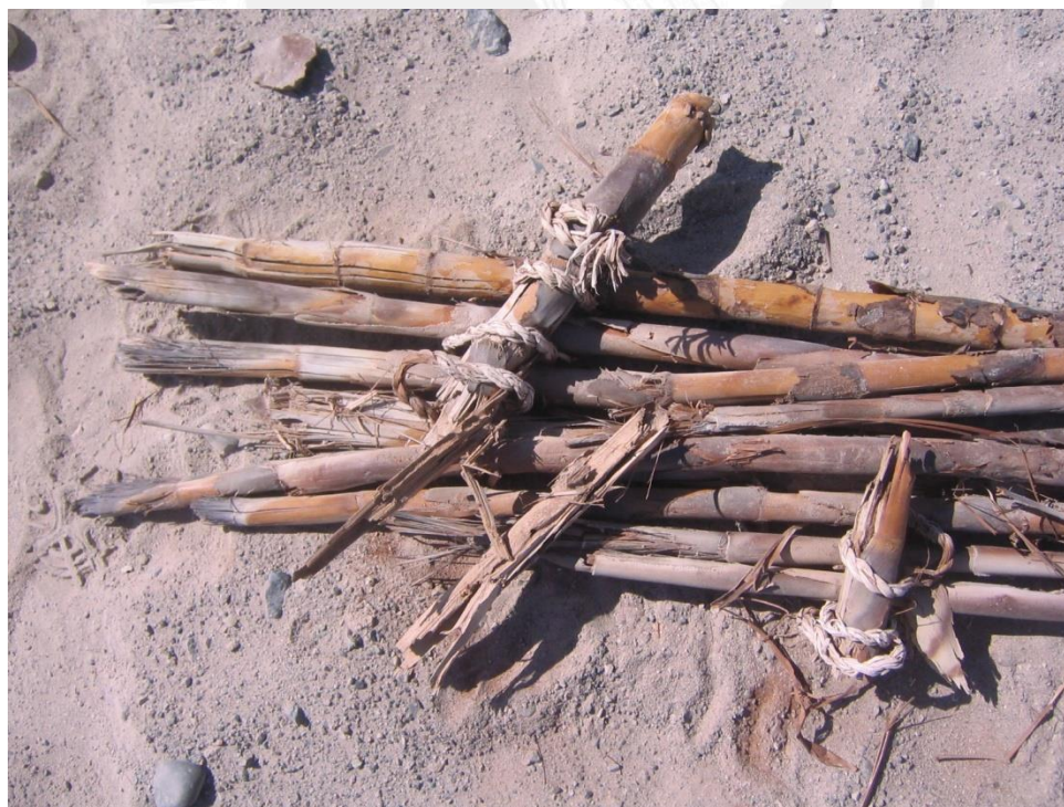
Figura 5.25: Detalle de los carrizos (caña) amarrados con sogá
