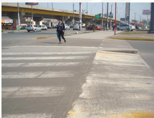
Figura 37. Cruce peatonal elevado al nivel de la vereda.
