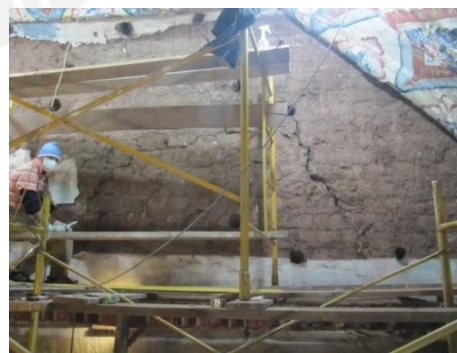
Figura 3.3. Grietas encontradas en el tímpano de adobe del arco triunfal
