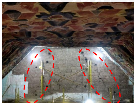
Figura 3.3. Grietas encontradas en el tímpano de adobe del arco triunfal
