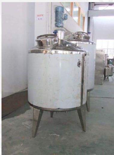
Gráfico 18: Tanque de almacenamiento de materia prima
