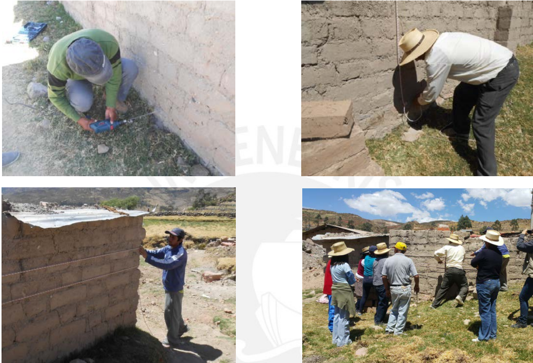
Figura 6. Sesión práctica de colocación de cuerdas horizontales y verticales en muro de cerco
