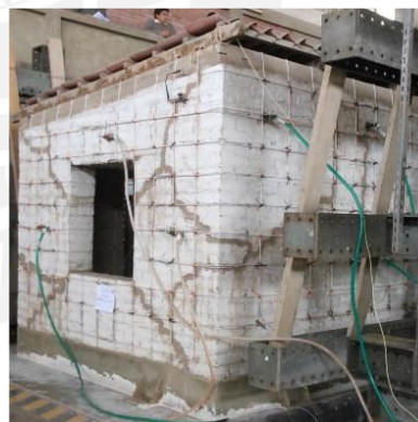
d) Casa reparada y reforzada
