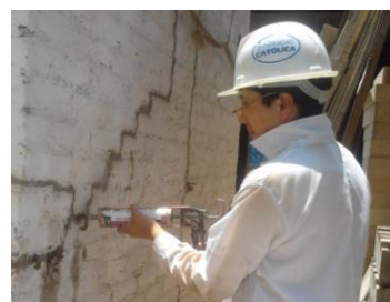
c) Inyección de barro líquido
