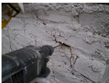
a) Uso de taladro eléctrico
