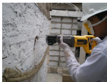
b) Uso de cuchillo eléctrico
