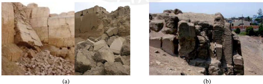
Figura 1.2. Daño en Huacas por sismos (a) Huaca La Centinela - Ica (adaptado de [2] ) (b) Huaca Mateo Salado – Lima (adaptado de [3]).
