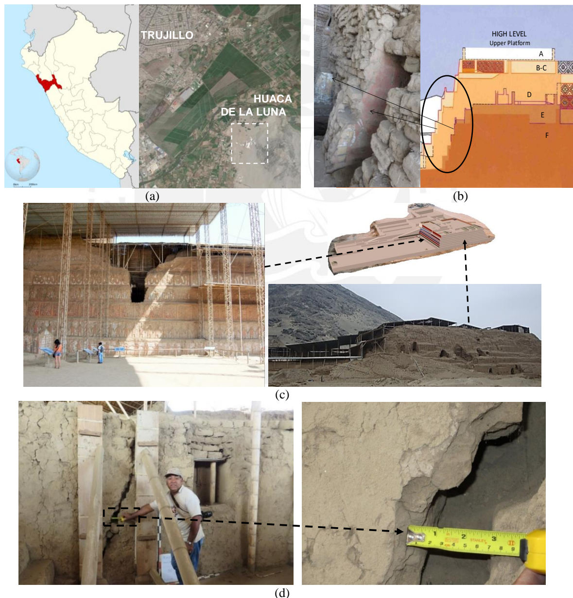
Figura 1.3. Huaca de La Luna (a) ubicación (b) etapas constructivas del templo (c) daño global en la fachada norte y oeste (d) daño local en muros.
