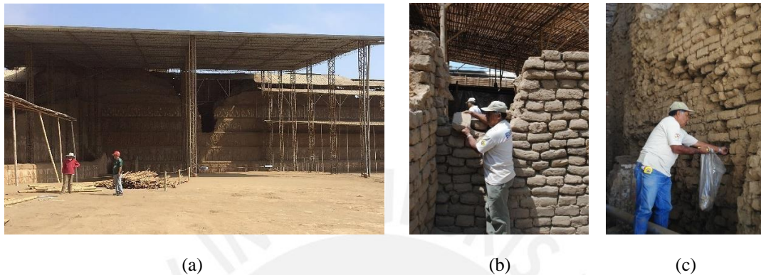
Figura 3.1. Vista general de Huaca de la Luna y sus paredes (a) Fachada Norte (b) adobes usados para la caracterización mecánica y (c) proceso de extracción del mortero [51].
