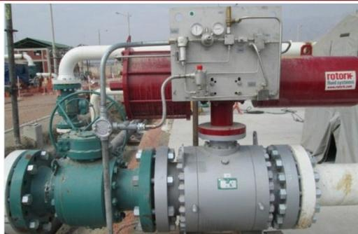
Figura 2.8. Válvulas de control de flujo de agua.
