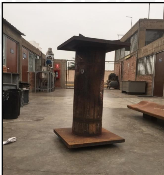
Figura 2.1 Tubería usada para la evaluación.
