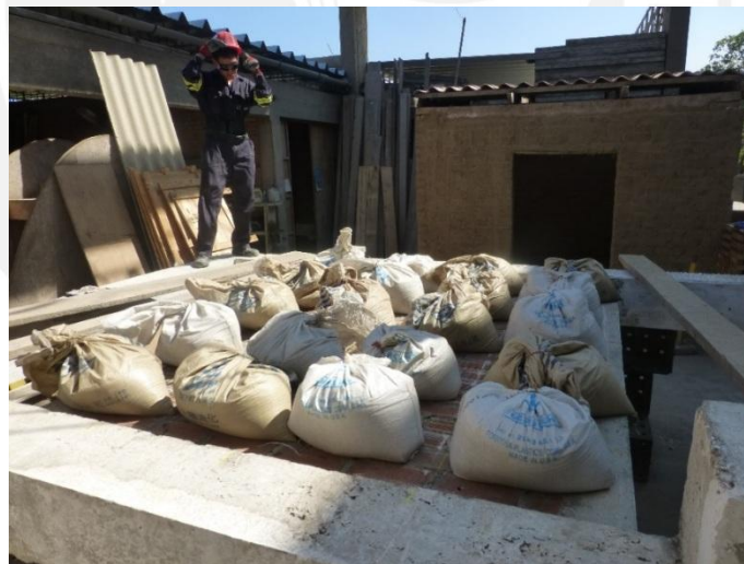
Foto 64. Colocación de primera hilada.
