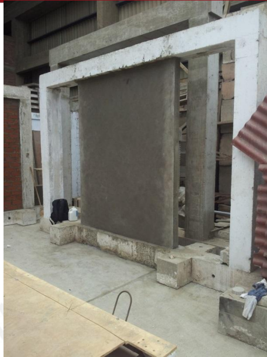
Foto 40. Tabique finalizado y tarrajeado.
