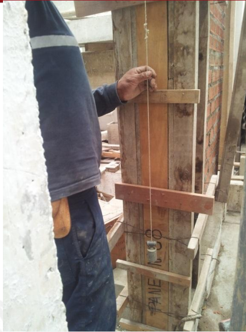
Foto 36. Aplomado de encofrado para columnetas.
