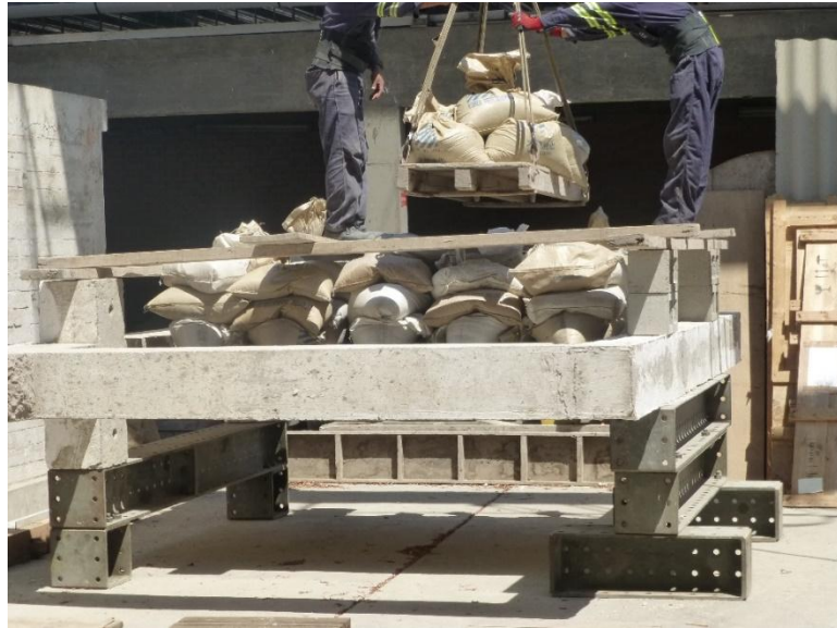
Foto 70. Colocación final bolsas en la cuarta hilada.
