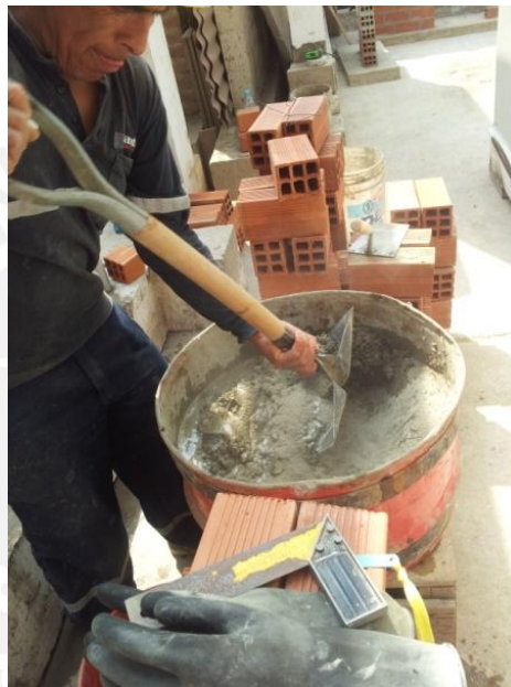
Foto 35. Preparación de mortero de cemento para asentado de ladrillo.
