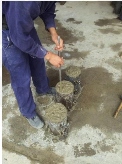
Foto 39. Probetas de concreto de 175 kg/cm 2 .
