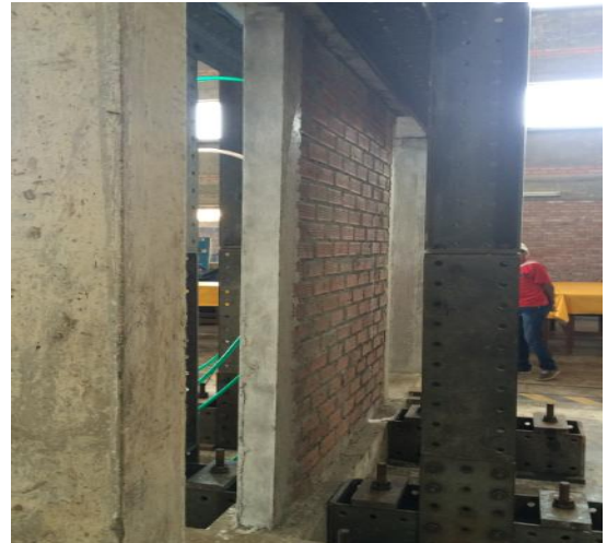
Foto 58. Fase 3 sin fallas.
