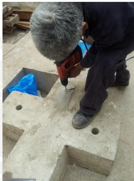
Foto 33. Perforación de puntos donde va anclado el refuerzo vertical.
