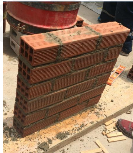
Foto 18. Murete de ladrillo pandereta.
