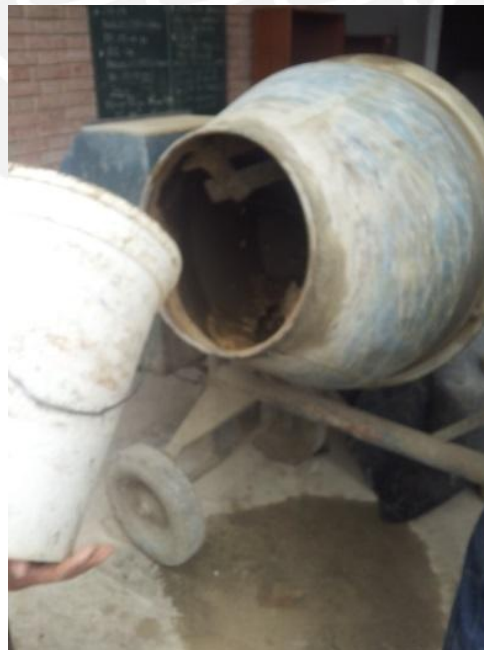
Foto 37. Mezcla de concreto en el trompo.
