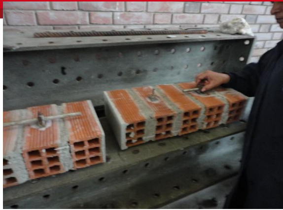
Foto 8. Colocación de bases de instrumentación con adhesivo.
