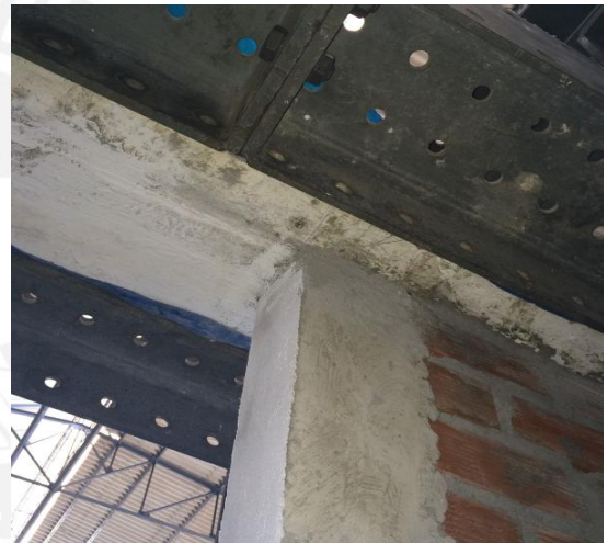
Foto 59. Fase 4 sin fallas.
