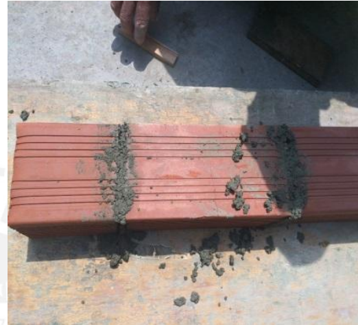
Foto 17. Asentado de la primera hilada sobre panel de madera.
