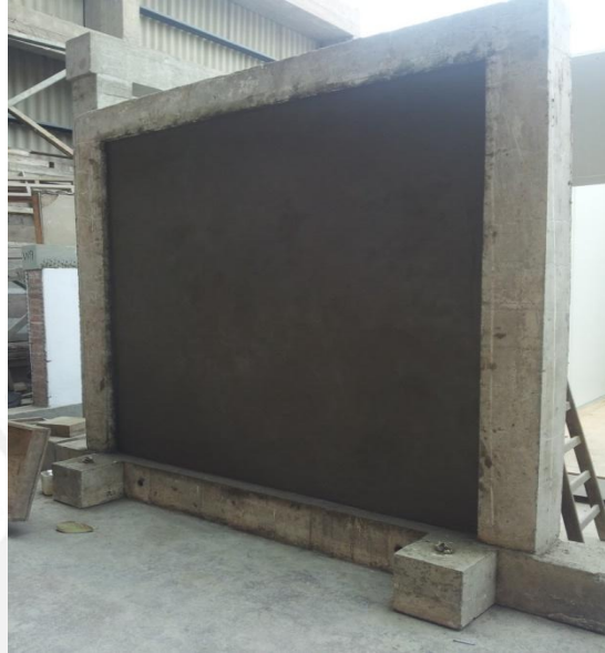
Foto 32. Tabique finalizado y tarrajeado.
