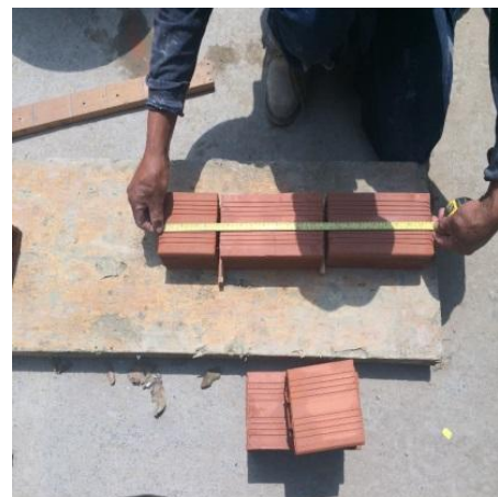
Foto 16. Alineamiento de primera hilada del murete de 0.60x0.60 m sobre panel de madera.
