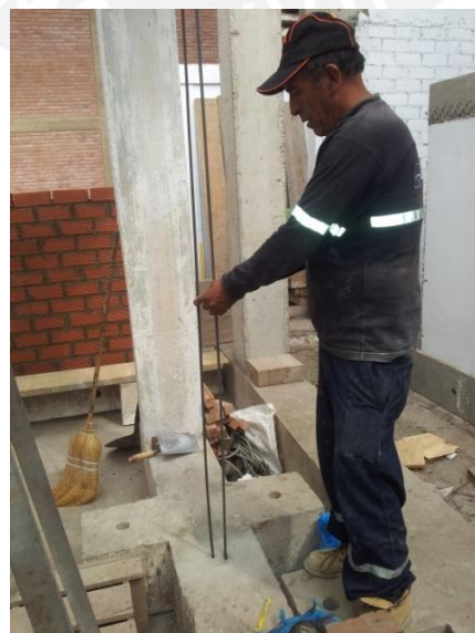
Foto 34. Armado de refuerzo vertical.
