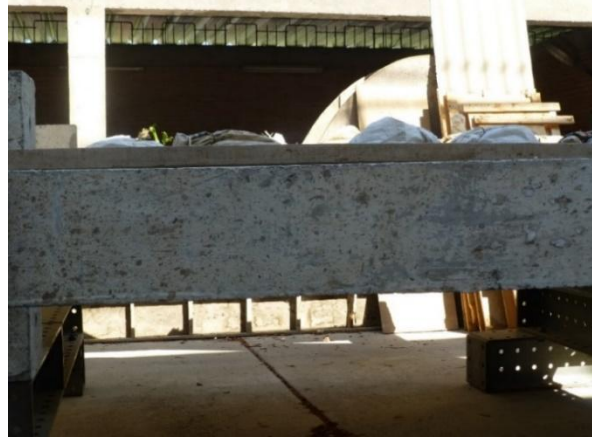
Foto 65. No se presentan fisuras con la primera hilada de bolsas de arena.
