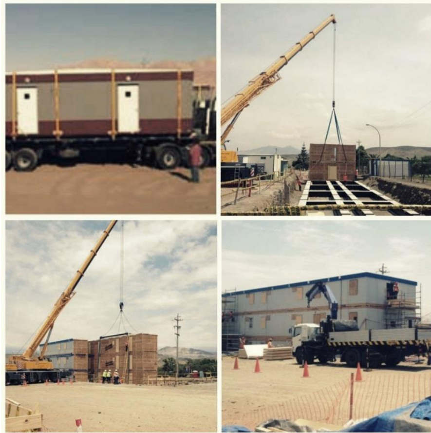
Ilustración 4. 6 Proceso de transporte y ensamblaje de módulos. 33
