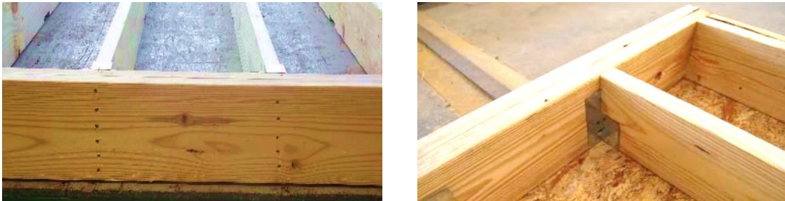
Ilustración 3. 3 Uniones de entre los pies derechos y soleras
