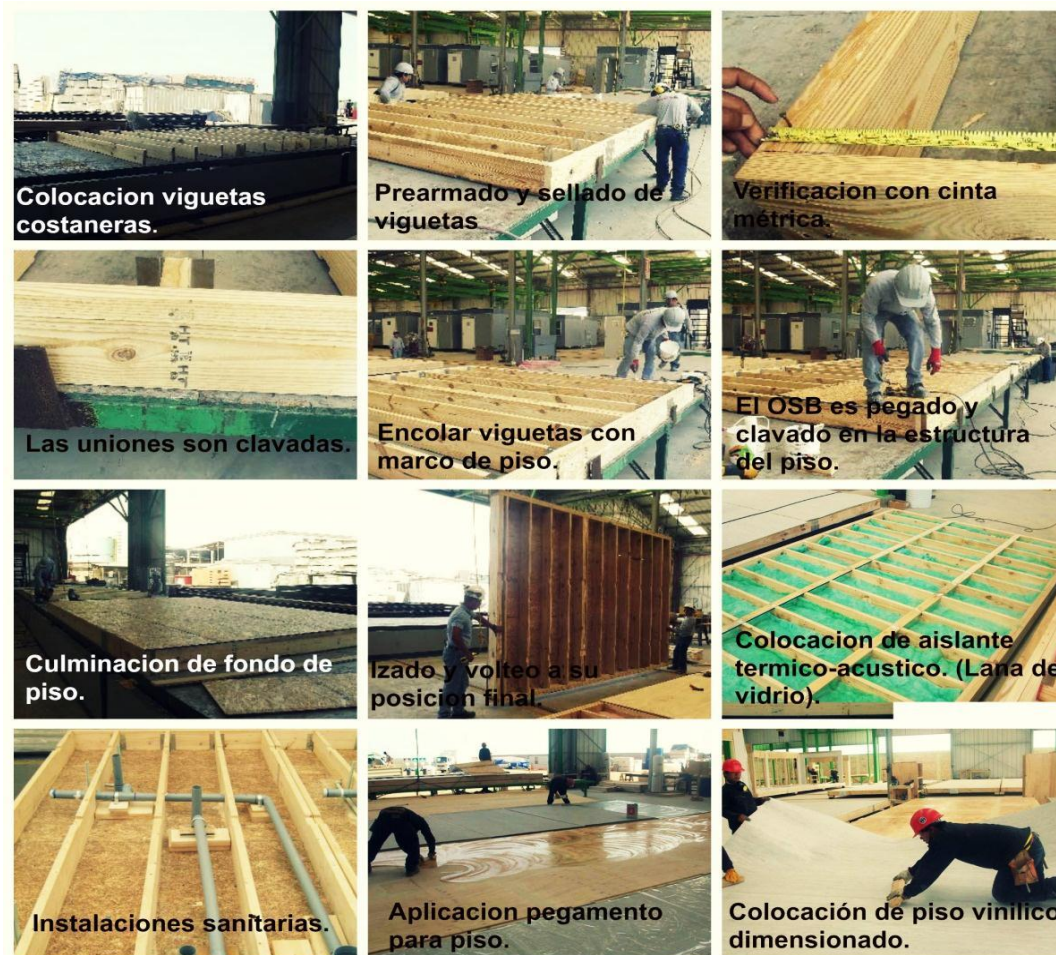
Ilustración 4.1 Proceso constructivo del armado de los pisos.
