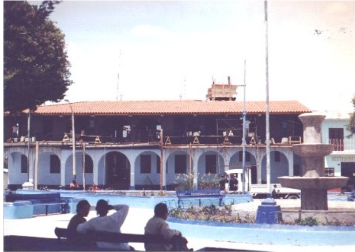
Foto 11: Local del Municipio en construcción
