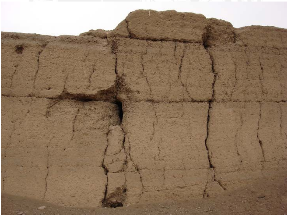
FOTO 4. Serie de tapiales de la Pirámide A de Mateo Salado (nótese los entrepaños)
