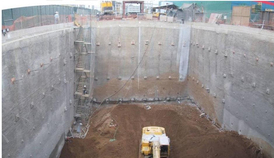
Figura 2. 9 Anclajes “Soil Nailing”. Estación Los Orientales Metro de Santiago Línea 4<sup>16</sup>
