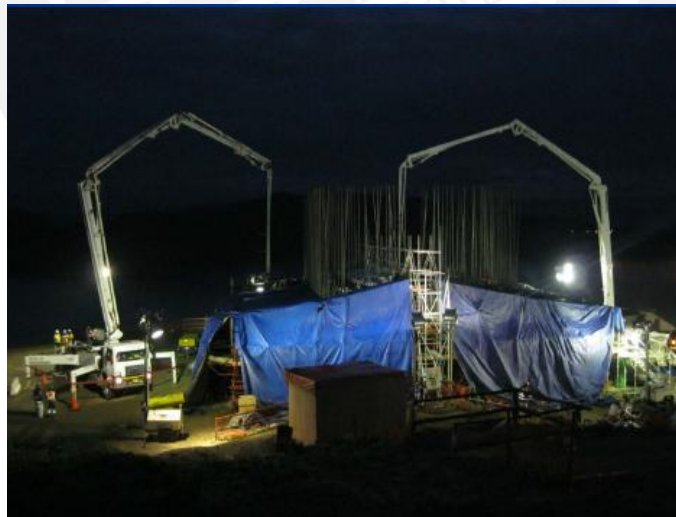
Figura 1.13: Armado de microclima para vaciados en bajas temperaturas. Fuente: Proyecto Antapaccay - Expansión Tintaya - Cusco
