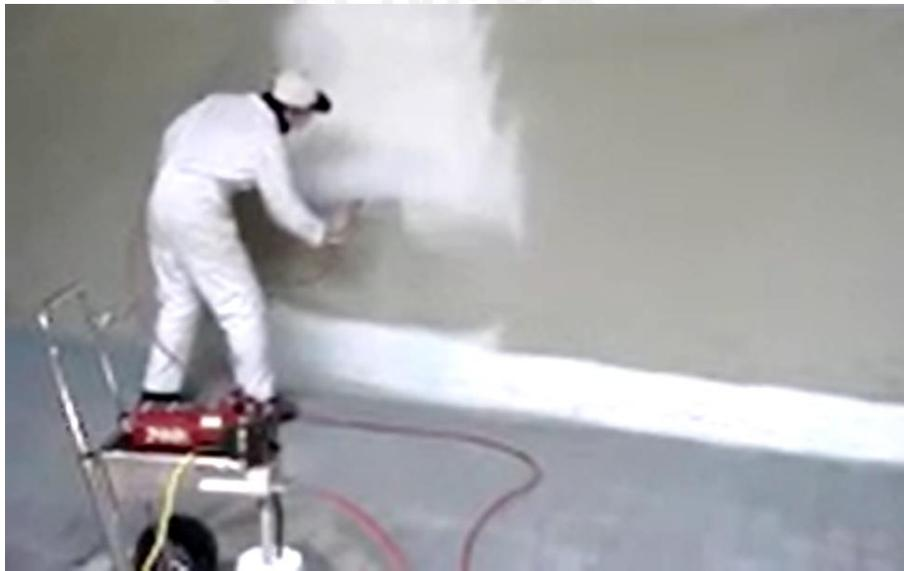
Ilustración 9. Aplicación de pintura con soplete.
