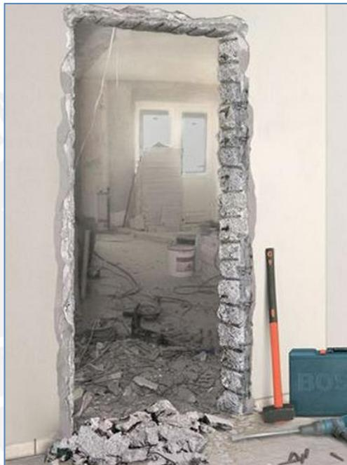
Ilustración 4. Corrección de vano de puerta.
