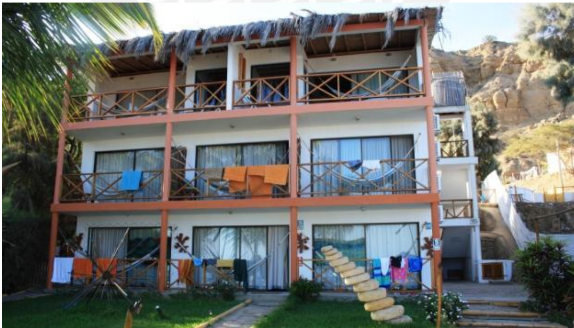
Edificio de Habitaciones
