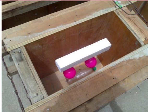
Figura 51: Encofrado del muro tipo 1.
