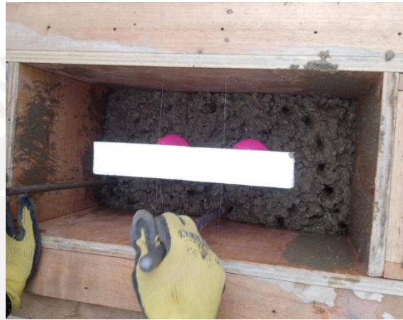
Figura 55: Compactación muro tipo 1.
