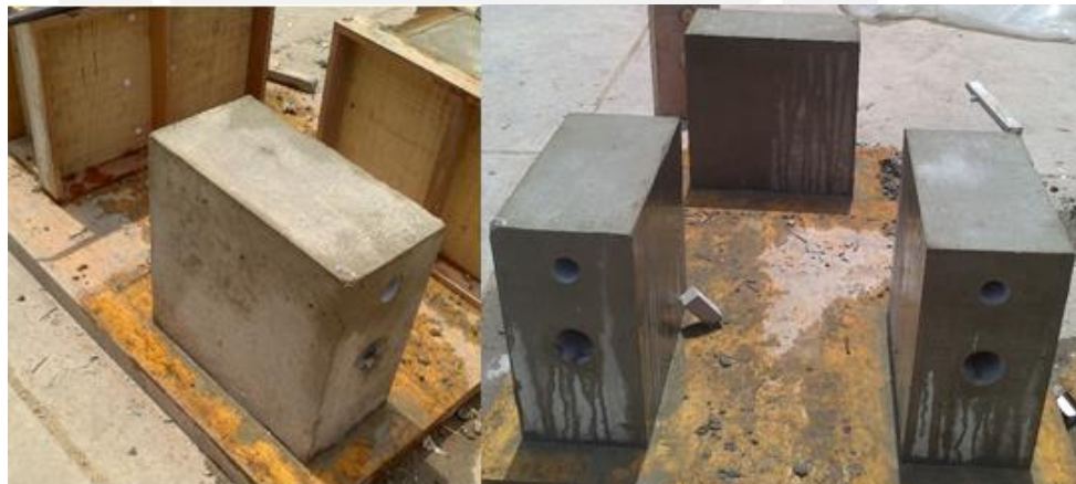
Figura 56 y 57: Desencofrado de los muros.
