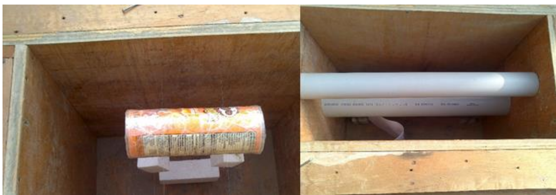
Figura 52 y 53: Encofrado del muro tipo 2 y 3.
