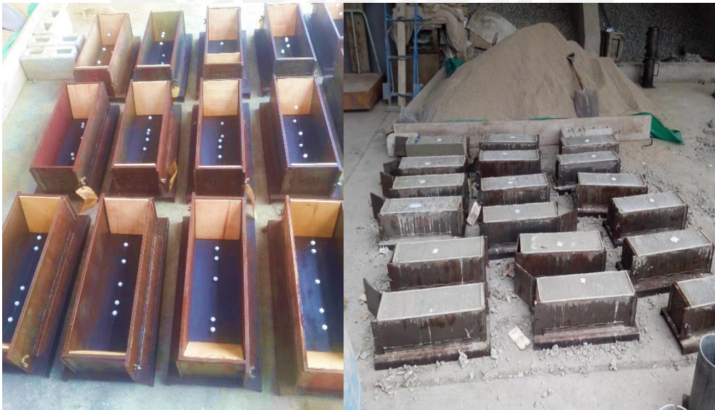
Figura 43 y 44: Encofrado y desencofrado de vigas.
