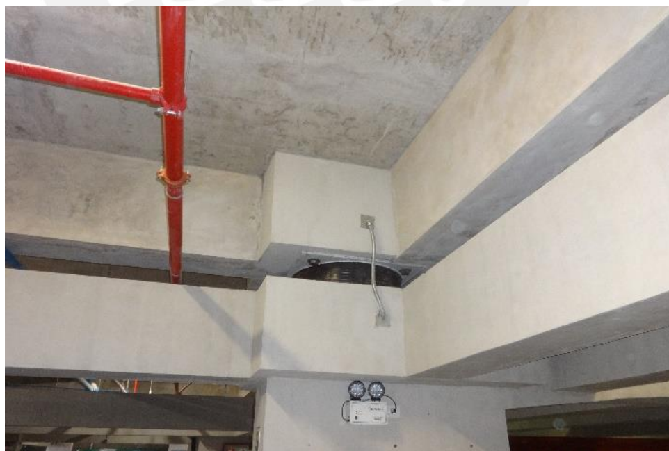
Fig. 2.5: Dados de concreto y vigas de conexión (Imagen propia)
