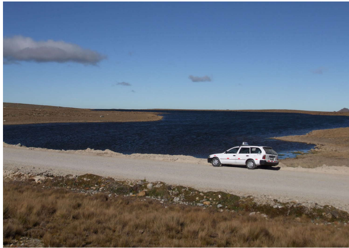
Figura 12. Vía afirmada que forma parte de la carretera Cajamarca – Bambamarca.
