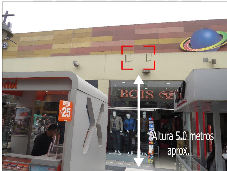
FIGURA 1-6: ANTENA PANEL MIMO 1-A-16 / 1-A-59
