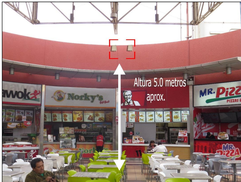
FIGURA 1-8: ANTENA PANEL MIMO 1-A-18 / 1-A-61
